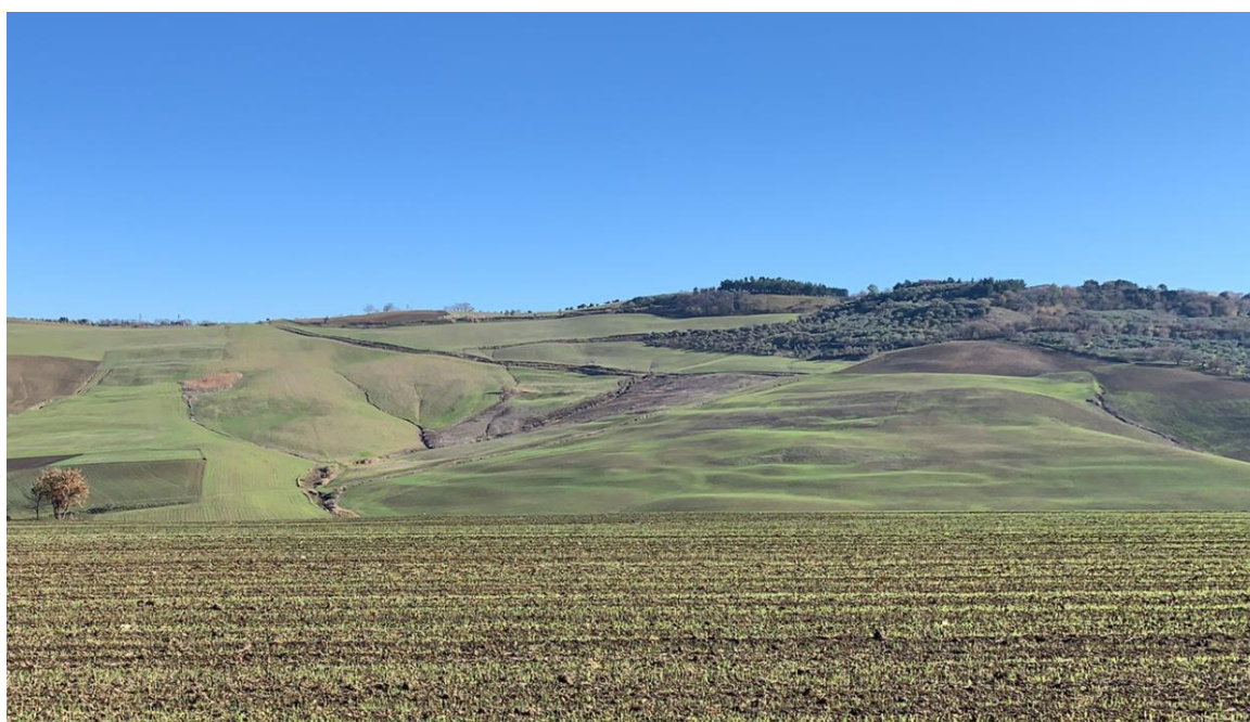
Figura 19 - Fenomeni di dissesto impostati sulla formazione delle Argille di Montesecco.
