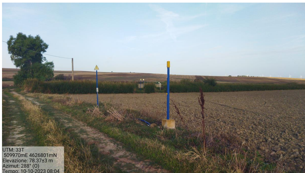
Figura 45 - Interferenza con gasdotto interrato nei pressi della WTG01
