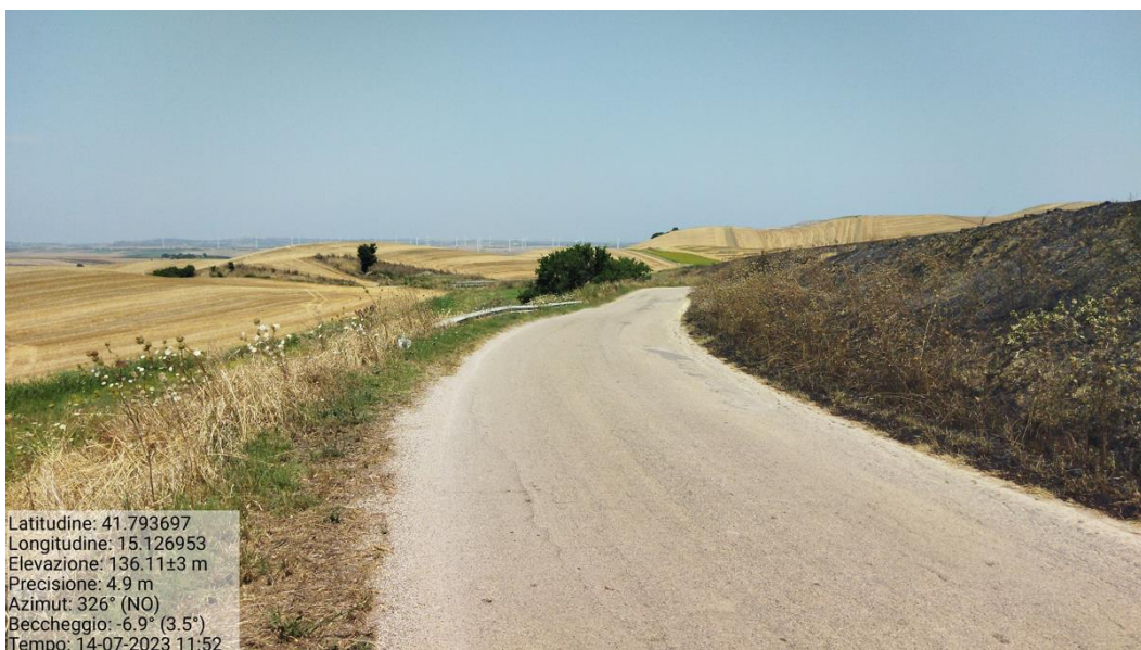
Figura 38 - Viabilità esistente da adeguare WTG 01 e WTG 02 – Punto di scatto 35
