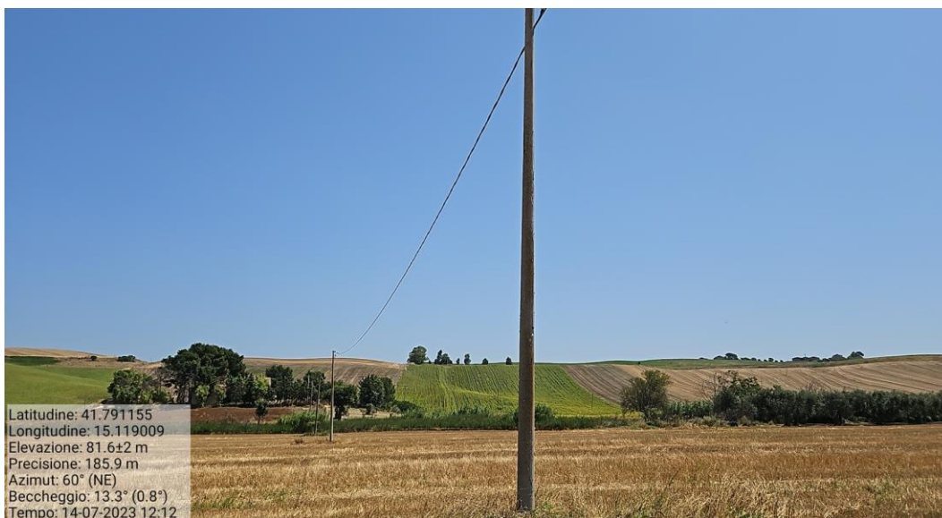
Figura 47 - Interferenza Linea BT nei pressi dell'area sitecamp
