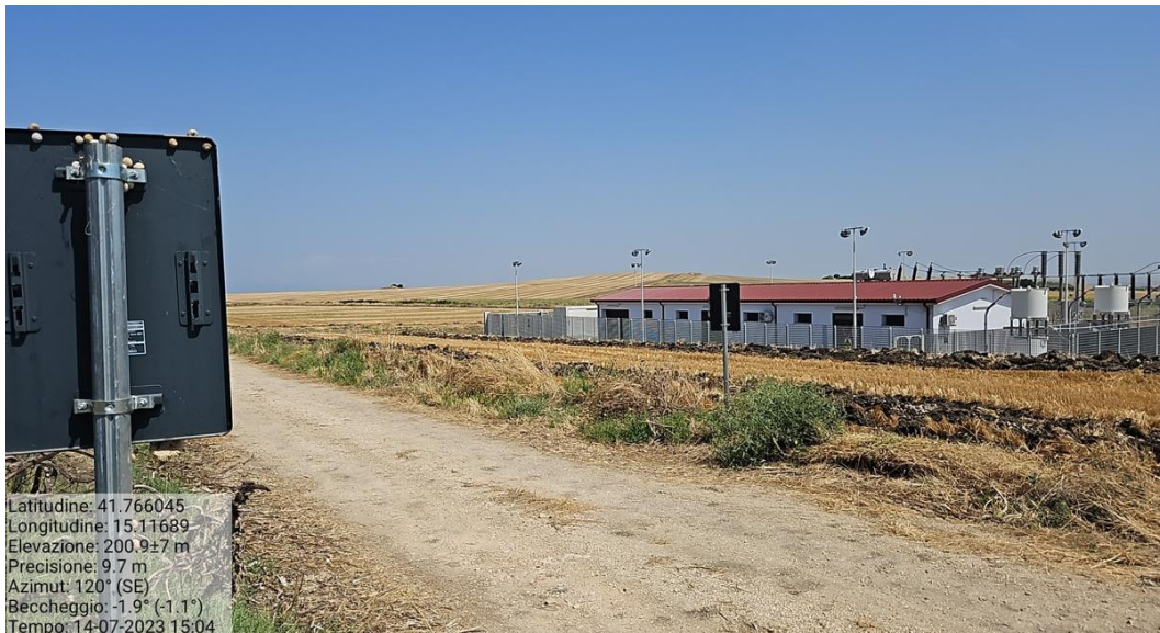
Figura 91 - Vista Stazione Elettrica a ridosso della viabilità di impianto
