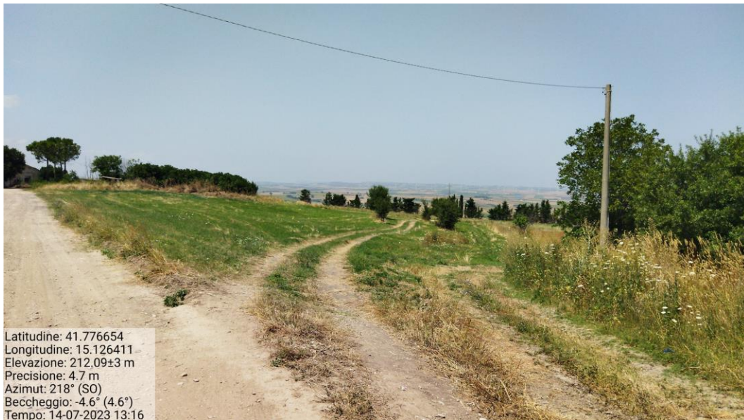
Figura 62 – Linea telefonica: gruppo di torri 3-6 - Punto di rettifica tracciato – Punto di scatto 79
