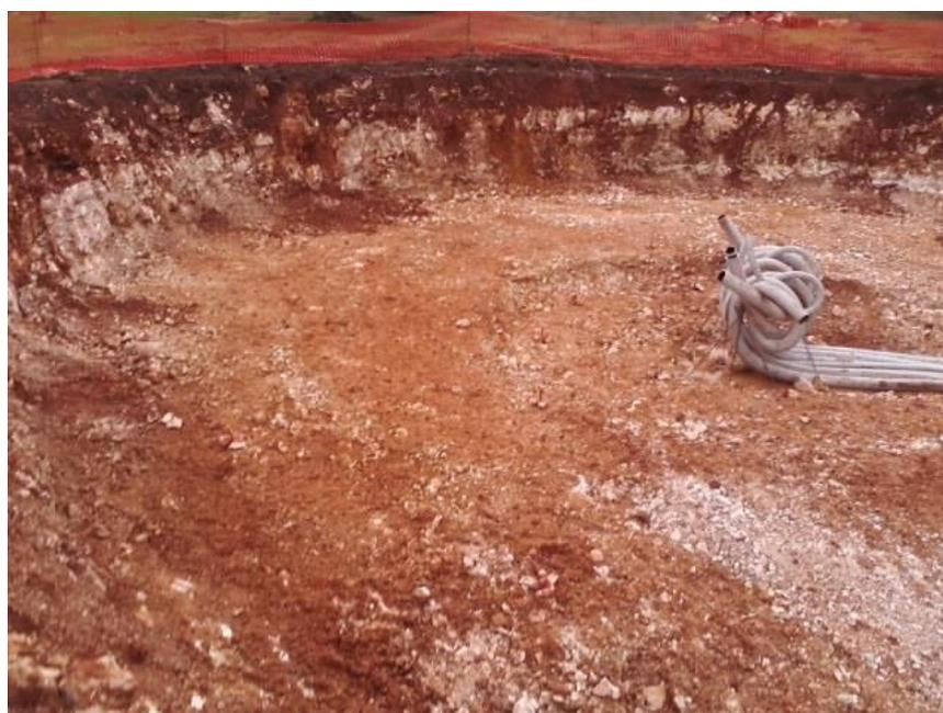
Figura 19: Particolare scavo di sbancamento per fondazioni WTG.
