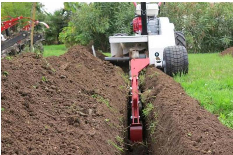
Figura 20: Particolare operazioni di scavo a sezione obbligata.
