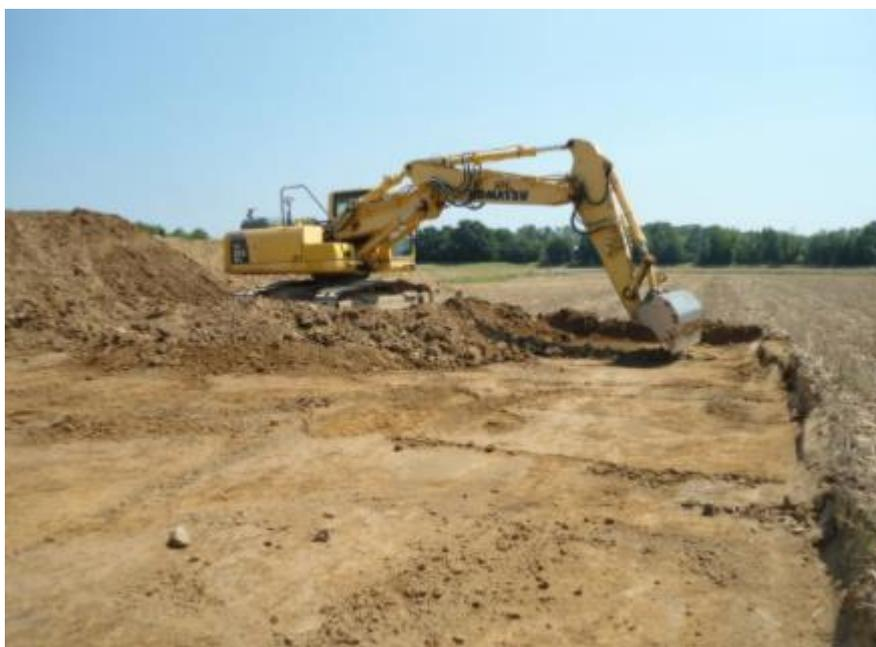
Figura 18: Particolare operazioni di scotico del terreno superficiale.
