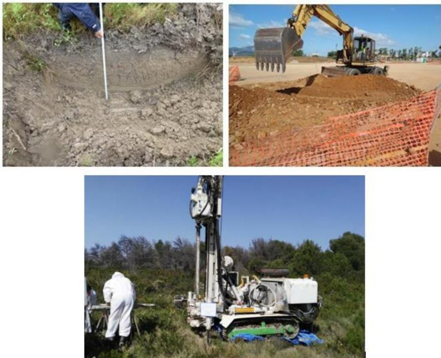
*Figura 24: Operazioni di caratterizzazione ambientale da scavo mediante escavatore meccanico (sopra) e da sondaggio (sotto).*
