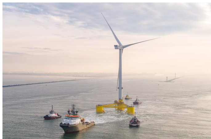
Figura 2: Immagine tipo di traino fondazione galleggiante - aerogeneratore.
