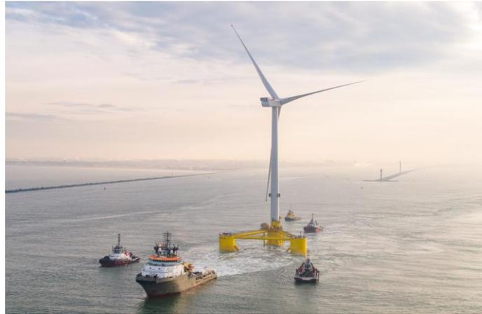
**Figura 41: Immagine tipo di traino fondazione galleggiante - aerogeneratore.**
