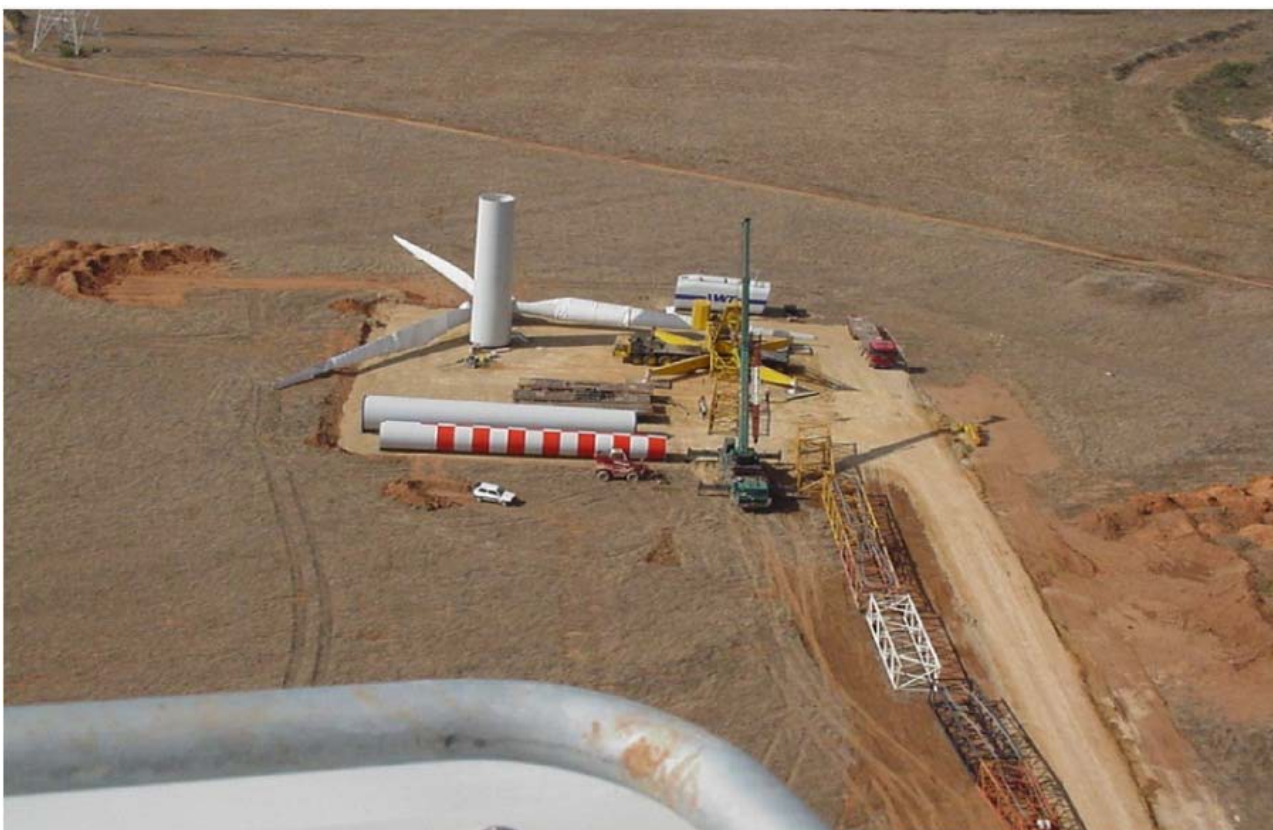
Figura 5 – Piazzola per il montaggio dell'aerogeneratore
