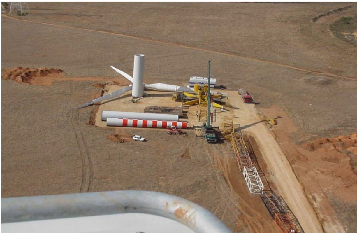
Figura 8 – Tipico piazzola per il montaggio dell'aerogeneratore
