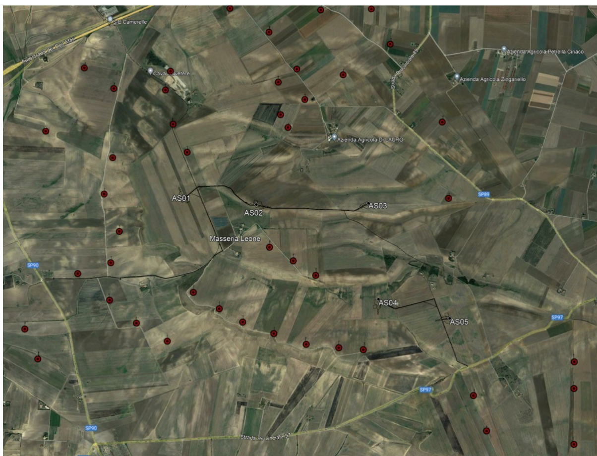
Fig. 5: Inquadramento territoriale del progetto con turbine eoliche esistenti (Fonte Google Earth)
