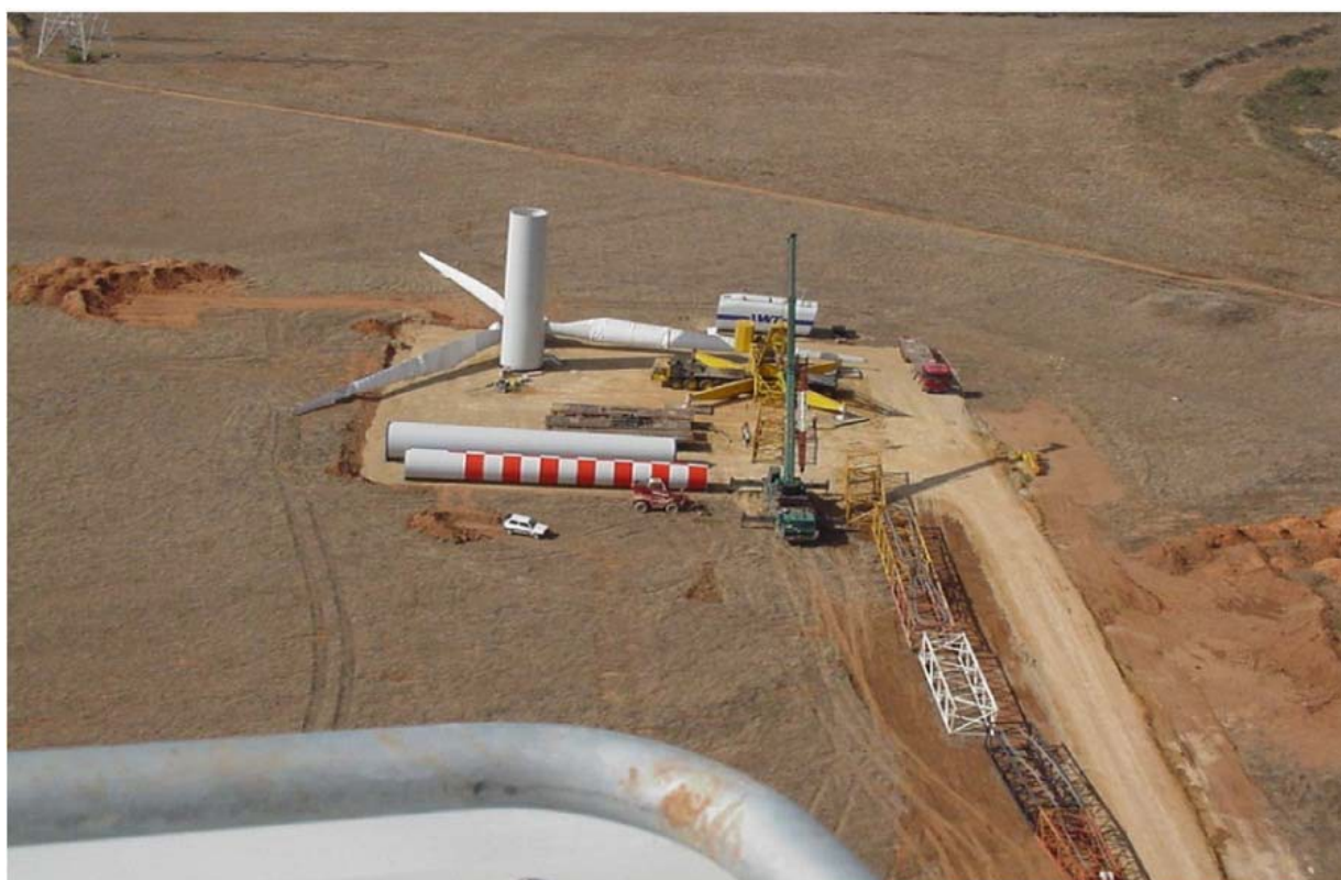
Figura 2 – Tipico piazzola per il montaggio dell'aerogeneratore
