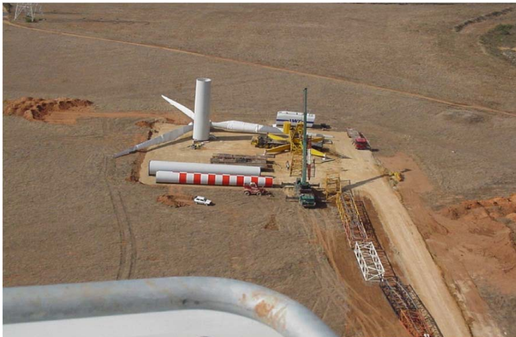
Figura 2 -. Piazzola per il montaggio dell'aerogeneratore
