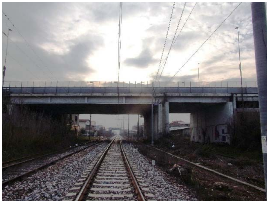
Figura 5 Cavalcaferrovia Strada Statale SS470
