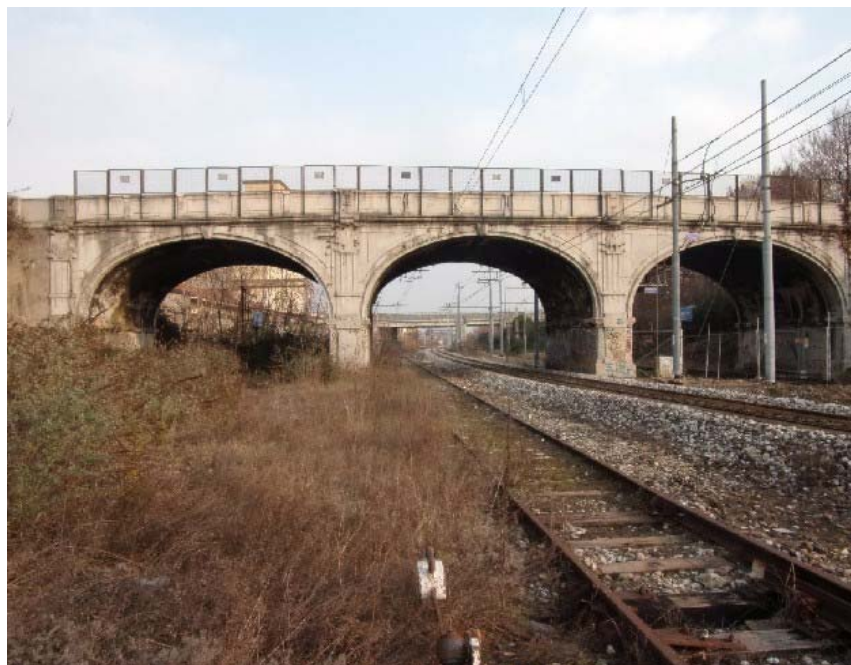
Figura 4 Cavalcaferrovia Via Piatti
