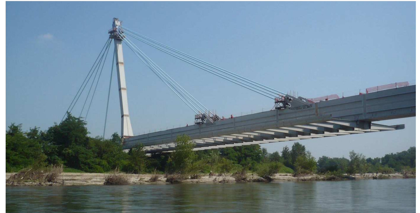
Fotografia 2: Vista del ponte sulla SS 591 durante le fasi di costruzione (Agosto 2008), ripresa fotografica dall'alveo del Fiume Adda.
