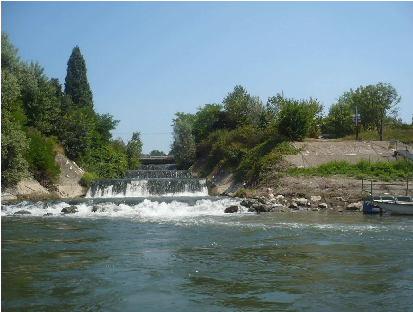
Fotografia 11: Vista del Serio Morto in corrispondenza della confluenza nel Fiume Adda presso Gombito
