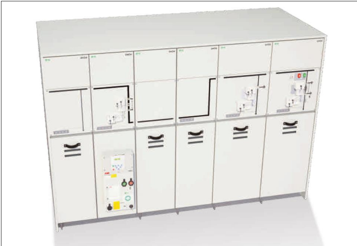
Figura 14: esempio tipico di quadro elettrico di MT
