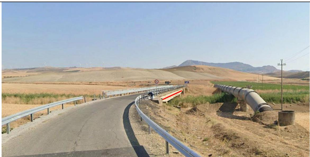
Figura 18 – Ponte sul fiume Gornalunga (la linea rossa indica la direttrice lungo cui sarà posata la canaletta che viste le sue esigue dimensioni si può considerare inglobata nel ponte)
