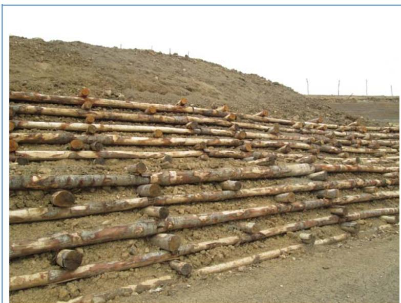
*Figura 20 – Esempio di opera in palificate in legname - Fonte HE*
