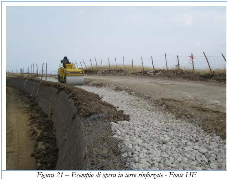
Figura 21 – Esempio di opera in terre rinforzate - Fonte HE
