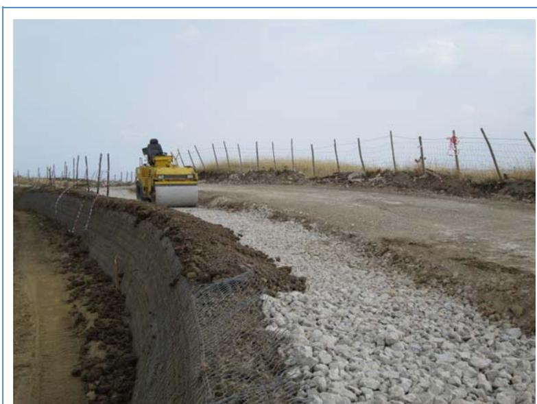
*Figura 47 – Esempio di opera in terre rinforzate - Fonte HE*
