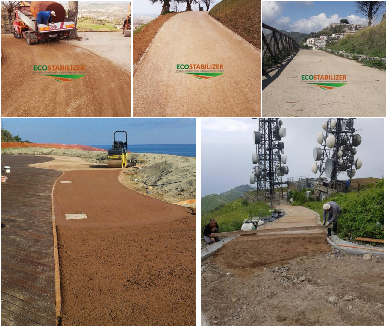
Esempio di posa terra stabilizzata Ecostabilizer Nature
