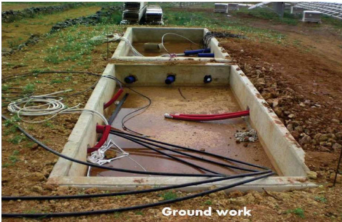
Figura 19 - Esempio basamento cabina
