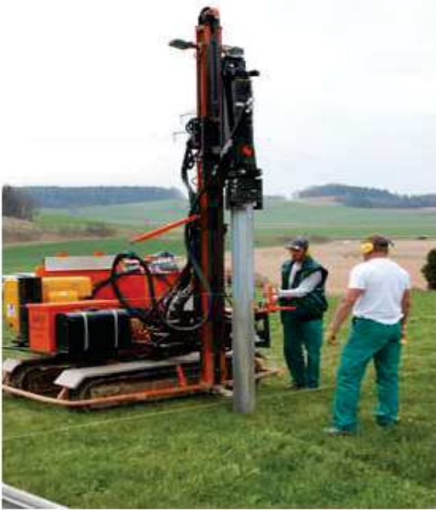
Figura 12 - Particolare di installazione
