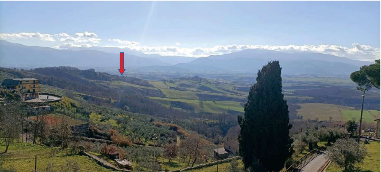
Figura 33 - Visuale 2 da Paliano convento Padri Passionisti. L'impianto risulta naturalmente schermato dalla collina antistante.
