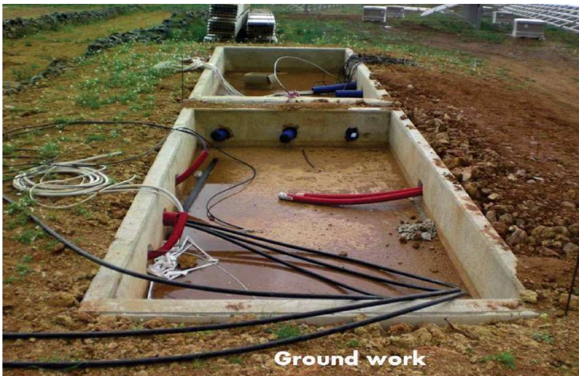
Figura 12 - Esempio basamento cabina
