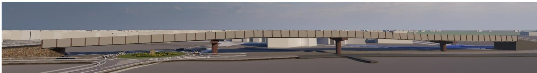
**IPOTESI 3** – Impalcato con finitura cromatica RAL 7047 (con costolature conci in RAL 8012), Pile e pulvini in calcestruzzo armato pigmentato in pasta RAL 8012. Rivestimento muro sinistra in bozze di pietra e a destra in cemento grezzo
