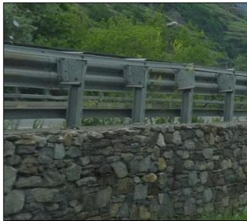
rivestimento muro di sostegno rilevato stradale
