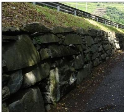
muratura di sostegno rilevato stradale in massi
