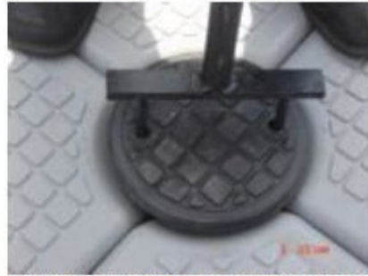
RUOTARE DI 45° IL CONNETTORE
