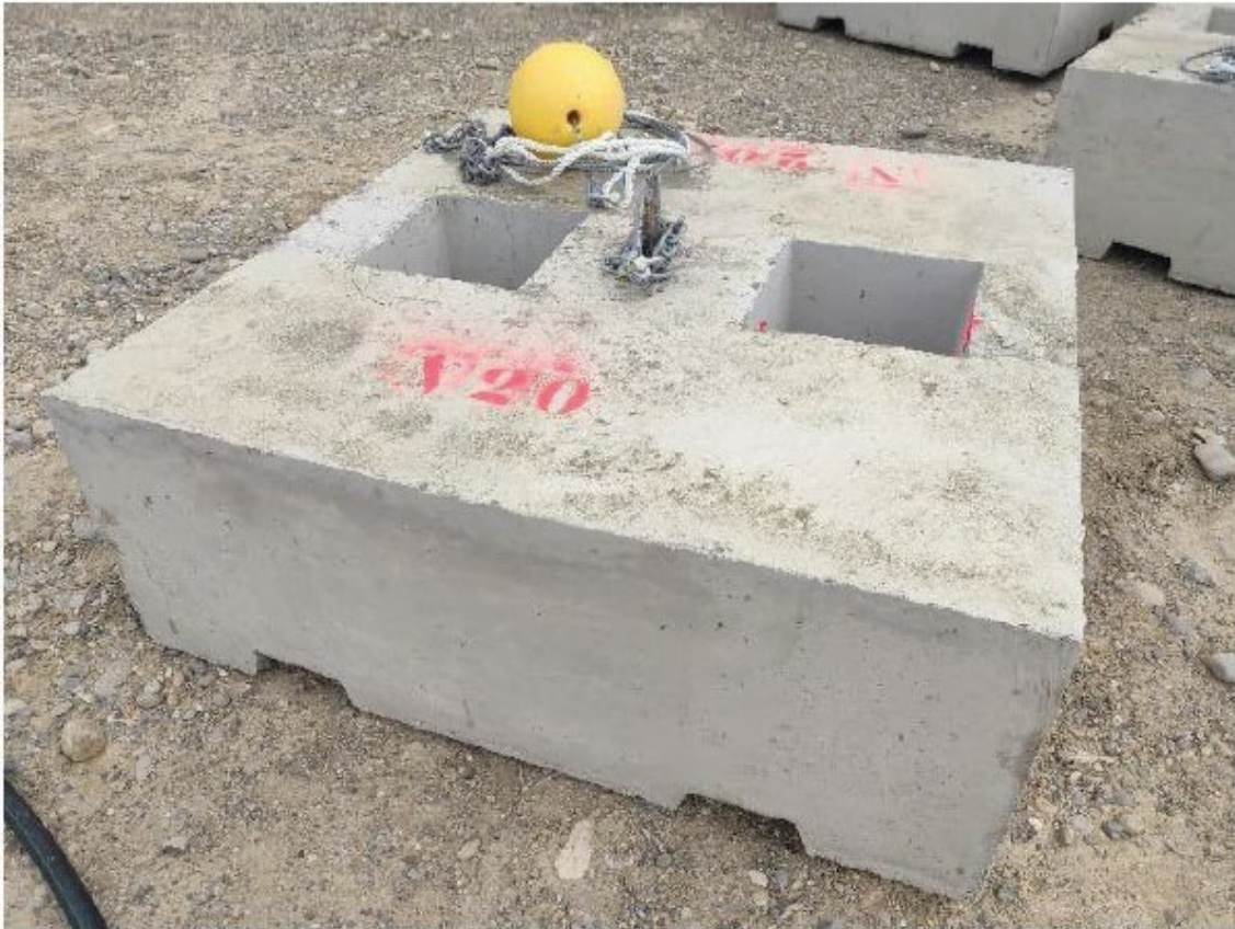
Figura 4-7: Corpo morto in cemento debolmente armato
