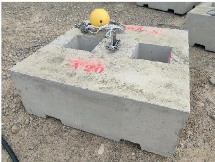
*Figura 4-8 Corpo morto in cemento debolmente armato*
