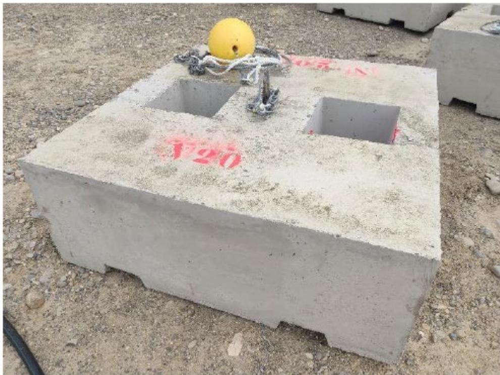
**Figura 2: Pesi morti in ghisa e cemento debolmente armato**
