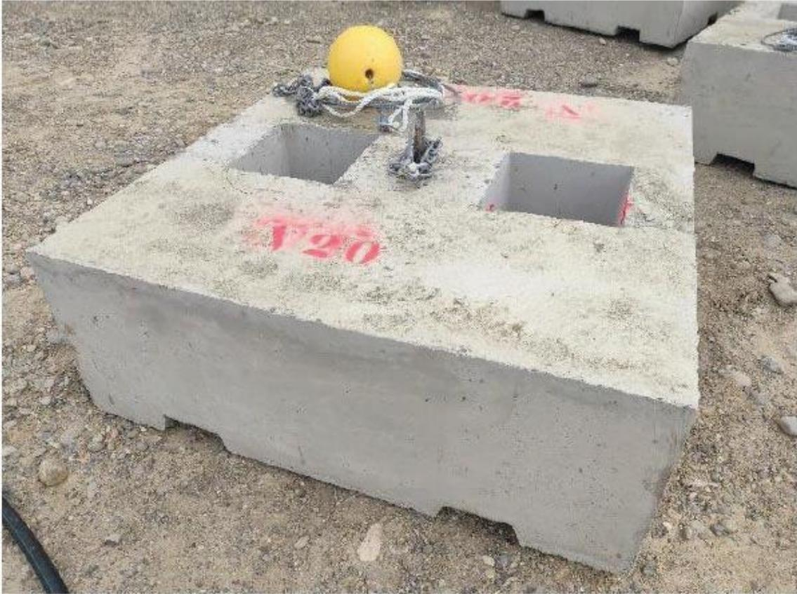
**Figura 7-10: Corpo morto in cemento debolmente armato**
