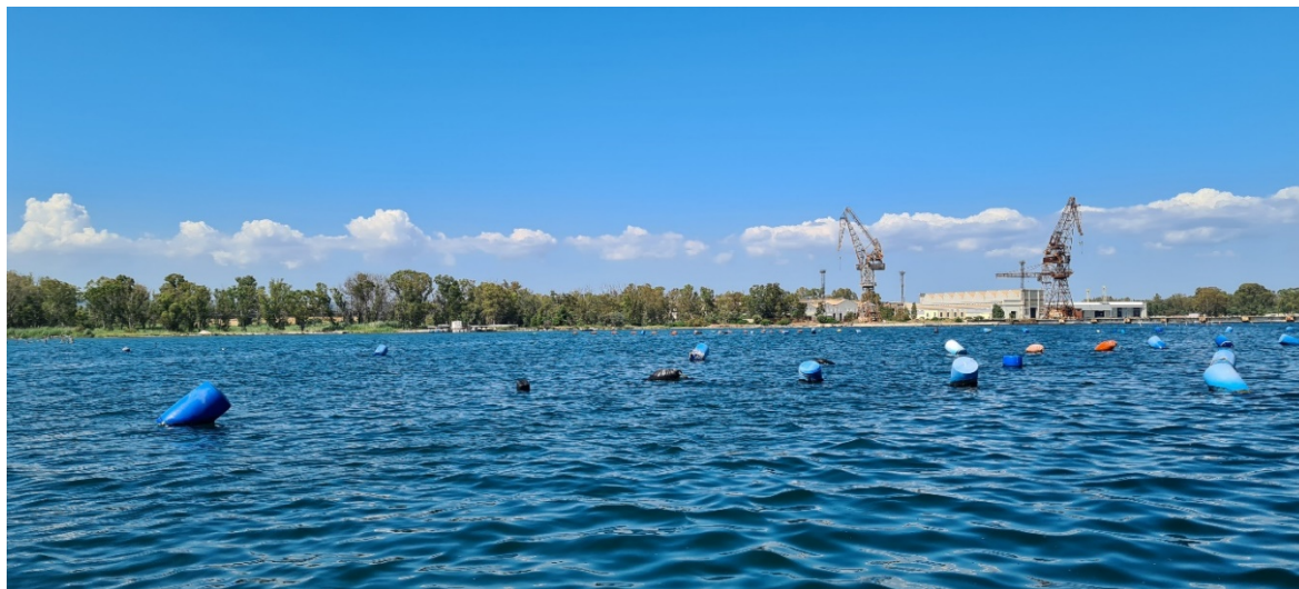
Figura 3-4: Specchio d'acqua nel I Seno del Mar Piccolo interessato dalla presenza dell'impianto fotovoltaico galleggiante.
