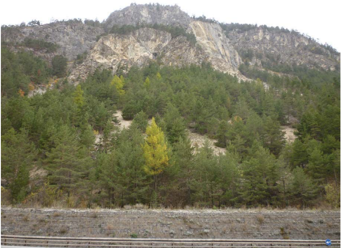
Settore di parete posto a monte dell'area dell'evento 2010, dove sono individuabili altre porzioni di roccia potenzialmente soggette a crollo anche per volumi consistenti.
