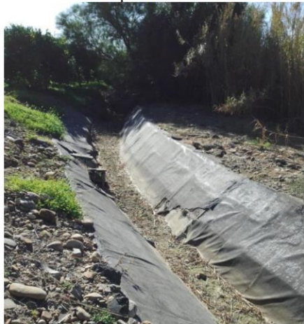
Tratto scoperto a livello terra
