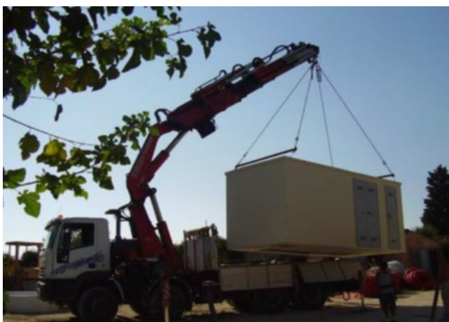
Figura 58: Rimozione delle cabine di raccolta e delle power station
