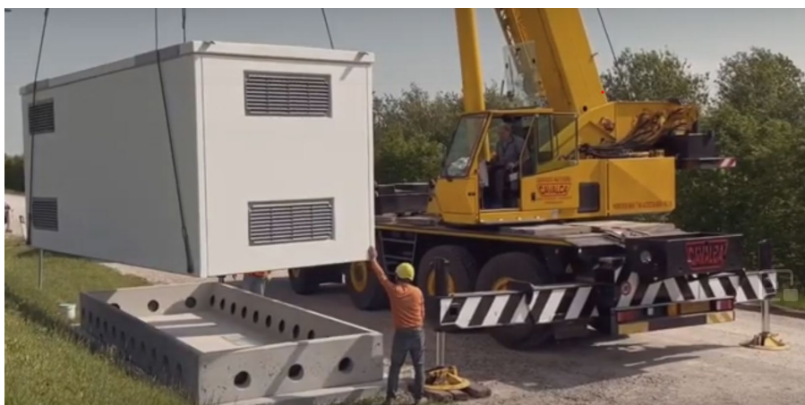
Figura 40: Fornitura e posa in opera delle cabine di campo e dei locali tecnici
