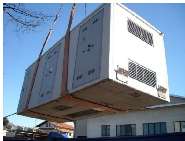
Figura 58: Rimozione delle cabine di raccolta e delle power station
