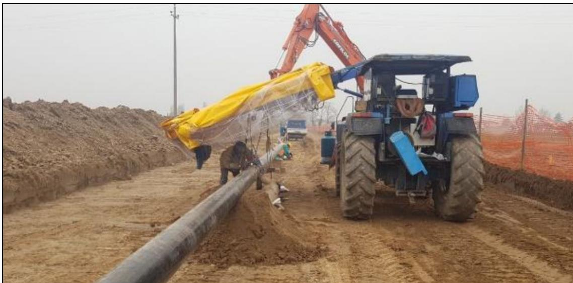
Foto 2-D: Esempio di saldatura manuale
