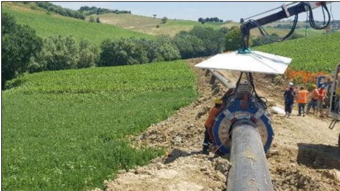
Foto 2-E: Esempio di saldatura automatica
