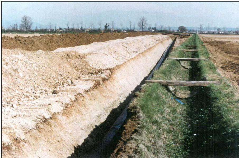
Foto 2-H: Tratto di condotta posata, si nota l'accantonamento dello strato humico separato dal materiale di scavo della trincea
