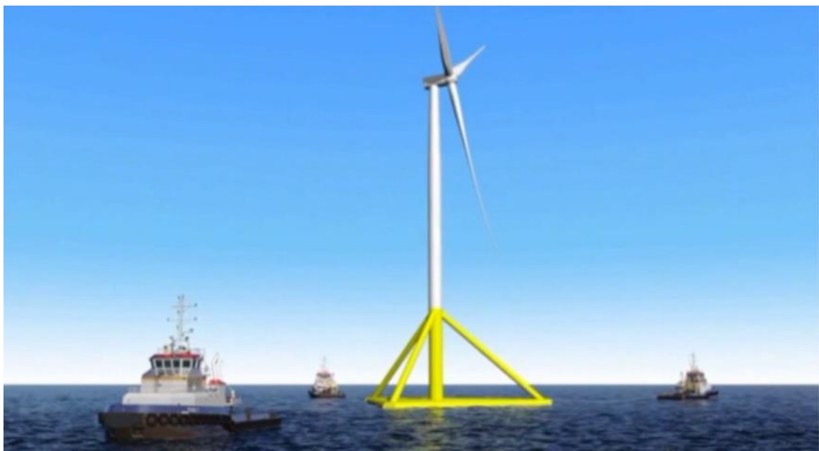
Figura 27 - Operazioni di rimorchio della turbina su piattaforma galleggiante
