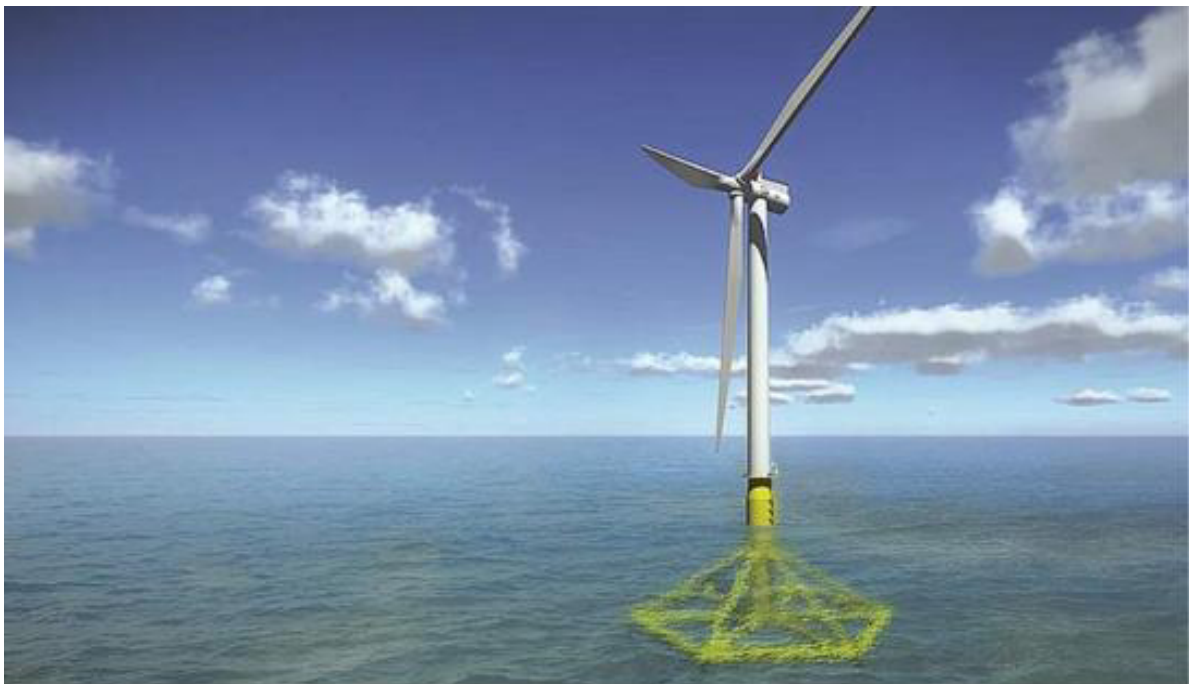
Figura 8 - Particolare della fondazione galleggiante di tipo floating
