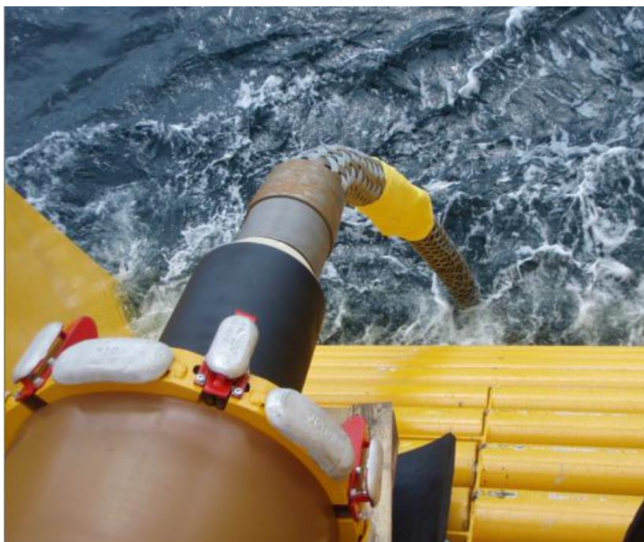
Figura 28 - Operazioni di installazione del cavo dinamico
