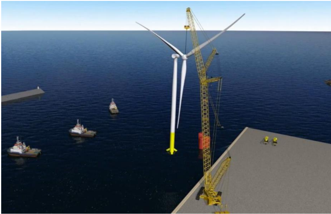
Figura 24 - Operazione di sollevamento del rotore della turbina
