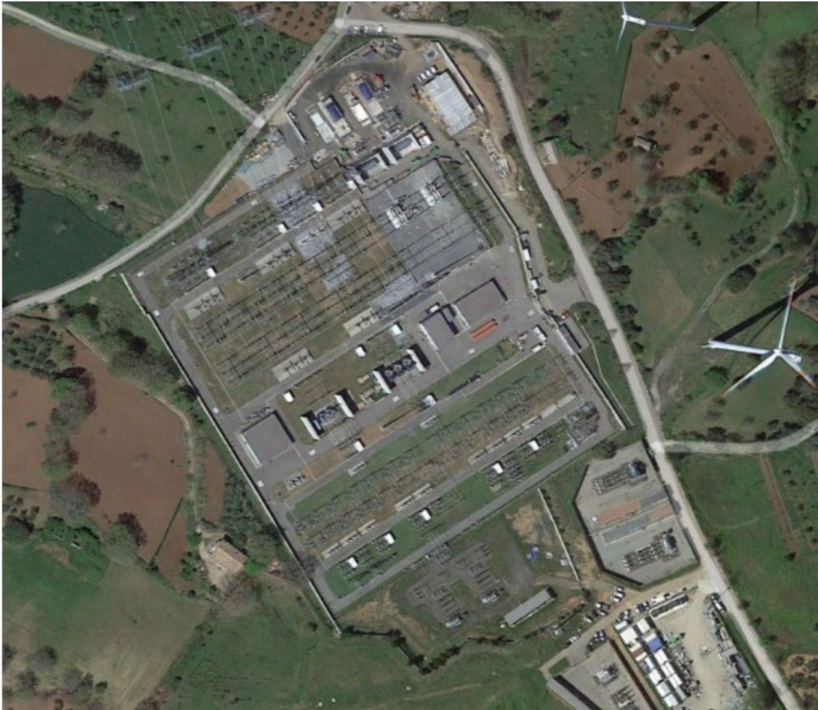
Figura 13: Stazione Elettrica di Terna a Maida
