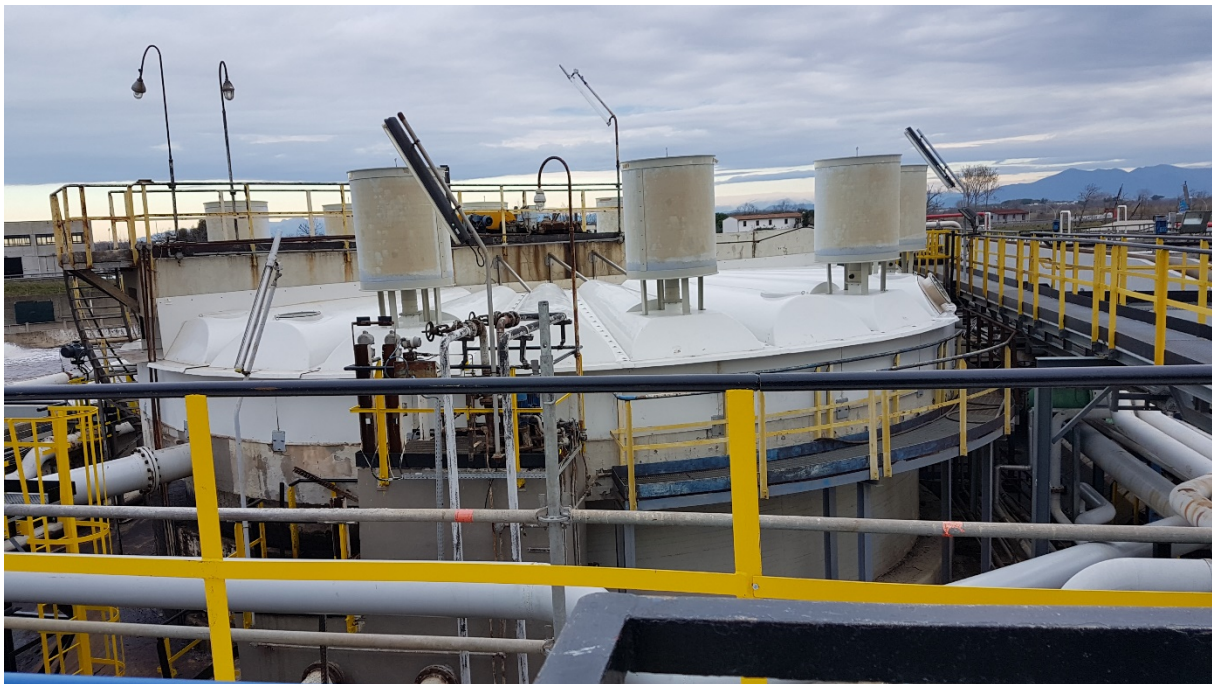
Figura 14. Copertura e filtri catalitici installati sulla vasca di flottazione MS2
