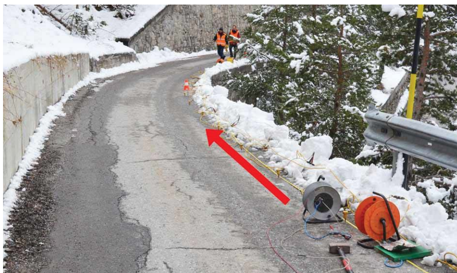
Figura 6 – Foto dello stendimento R3 – Vista da centro linea.
