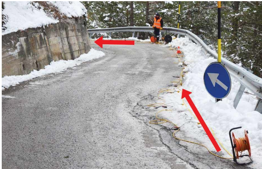
Figura 5 – Foto dello stendimento R3 – Vista da inizio linea.
