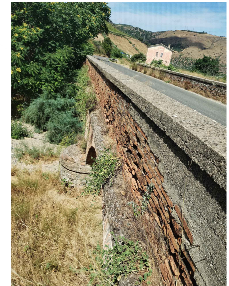
PV28 - Interferenza tra cavidotto MT e opera di attraversamento (I - C6)
