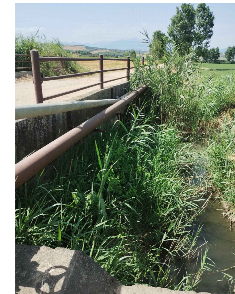
PV34 - Interferenza tra cavidotto MT e opera di attraversamento (I - C7)
