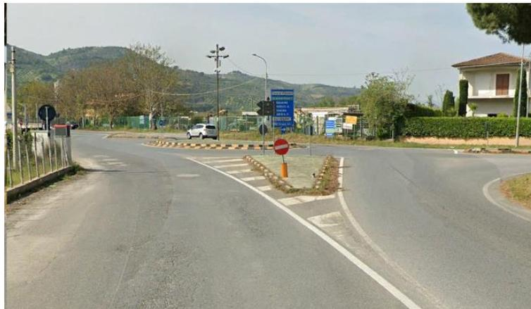
Figura 29: Punto di ripresa P16 (611381.00 m E, 4395306.00 m N) - L'isola spartitraffico con tutta la segnaletica stradale deve essere rimossa
