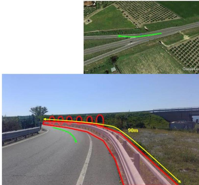
Figura 10: Punto di ripresa P2.02 (629982.39 m E 4390539.22 m N) - Rimuovere tutta la segnaletica stradale ed il guardrail a sinistra lungo lo svincolo per una lunghezza di 90 metri
