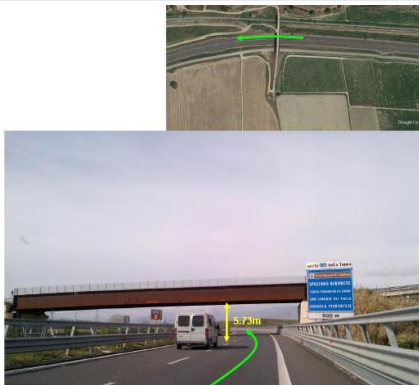
Figura 16: Punto di ripresa P7 (613925.86 m E 4398317.81 m N) - Altezza del ponte: 5,73 m.
