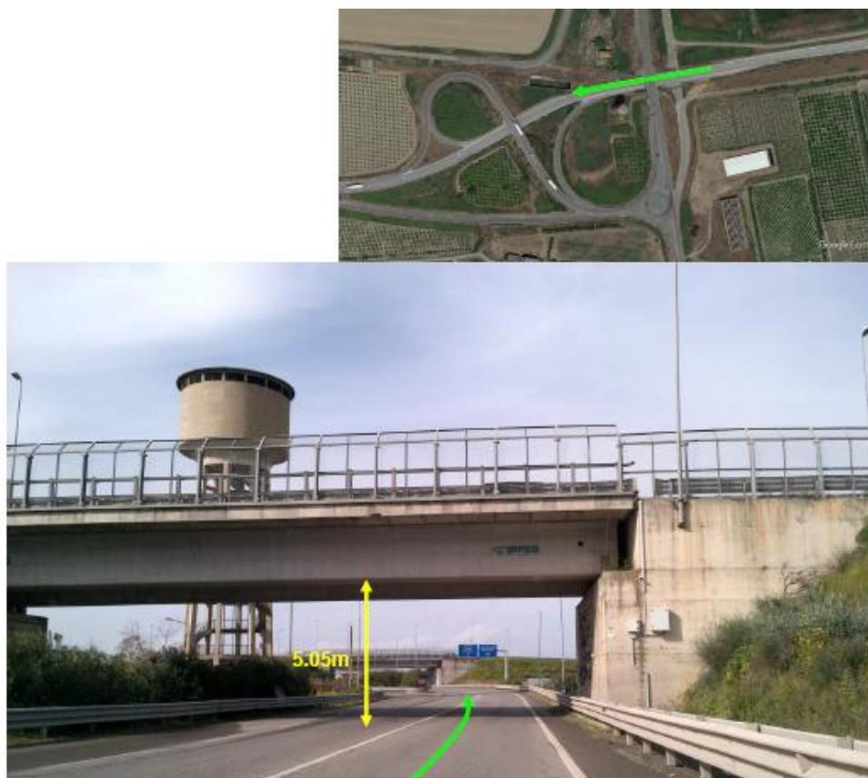
Figura 13: Punto di ripresa P5 (624156.90 m E 4398096.46 m N) - Altezza del ponte: 5,05 m.
