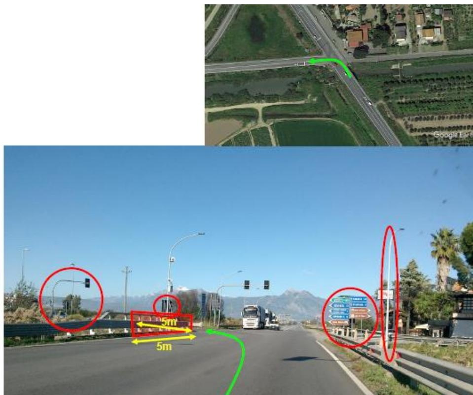
Figura 11: Punto di ripresa P3 (627178.66 m E 4398443.54 m N) - Prendere la SS 534 a sinistra. A sinistra rimuovere il guardrail 5x5m, la ringhiera e tutta la segnaletica stradale per avere uno spazio libero. Il palo della luce a sinistra deve essere girato in modo da non intralciare il passaggio del veicolo. Sulla destra rimuovere il palo dell'illuminazione stradale e tutta la segnaletica stradale per avere uno spazio libero.
