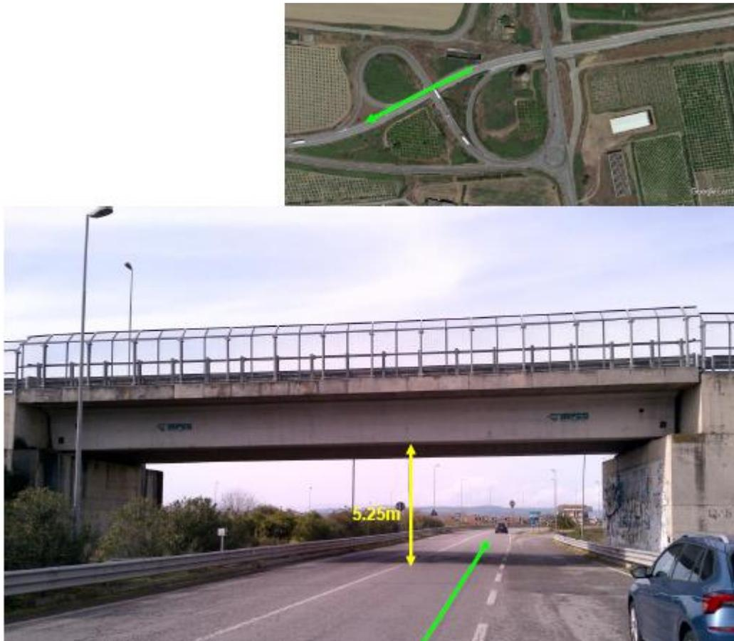
Figura 14: Punto di ripresa P6 (623991.42 m E 4398049.94 m N) - Altezza del ponte: 5,25 m.
