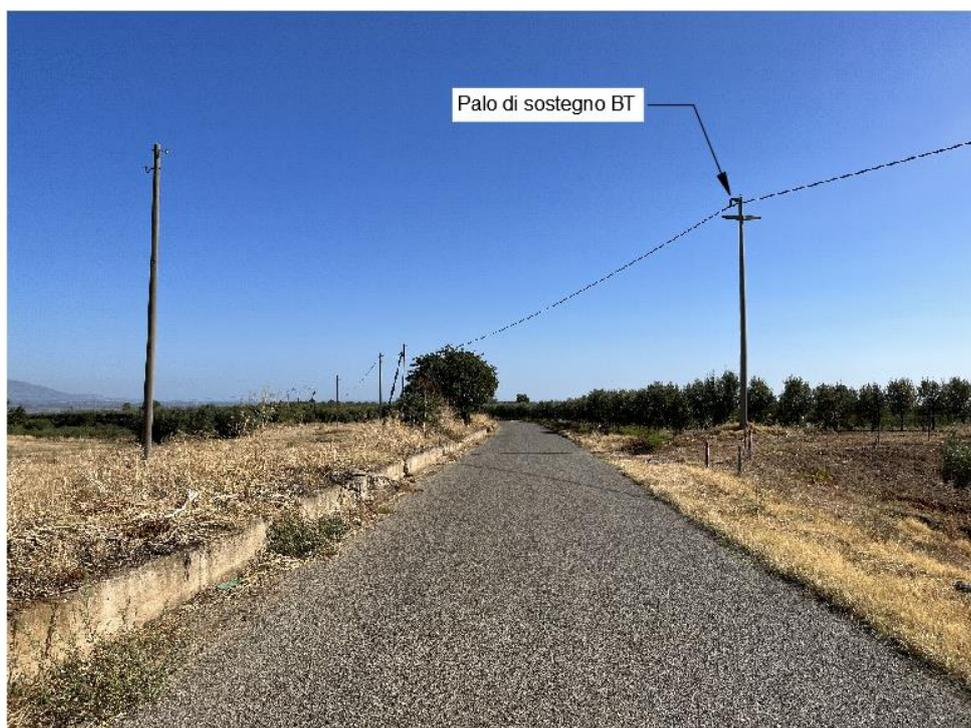
Figura 37: Interferenza tra la viabilità da adeguare/attraversamento cavidotto MT e linea aere BT (Punto I – LA34)
