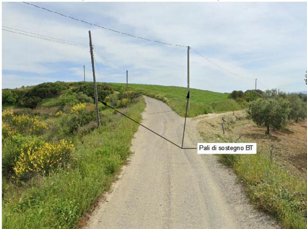
Figura 49: Interferenza tra la viabilità da adeguare/attraversamento cavidotto MT e linea aere BT (Punto I – LA54)
