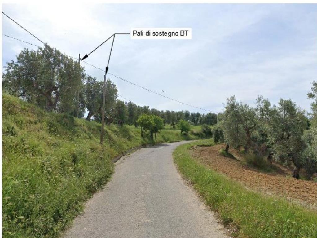
Figura 54: Interferenza tra la viabilità da adeguare/attraversamento cavidotto MT e linea aere BT (Punto I – LA66)
