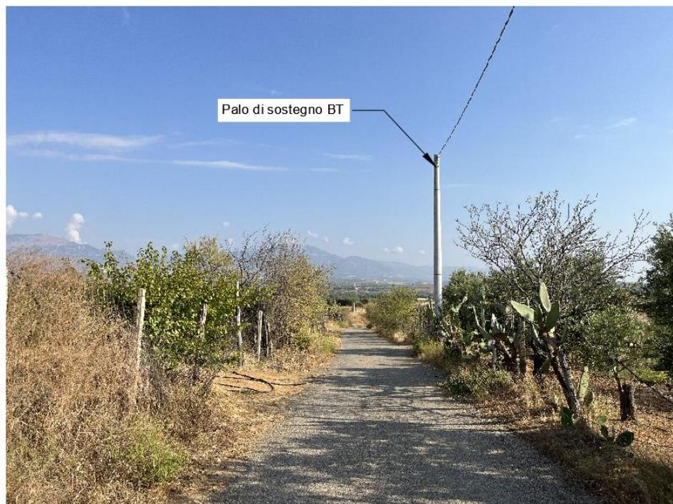
Figura 16: Interferenza tra la viabilità da adeguare/attraversamento cavidotto MT e linea aere BT (Punto I – LA1)
