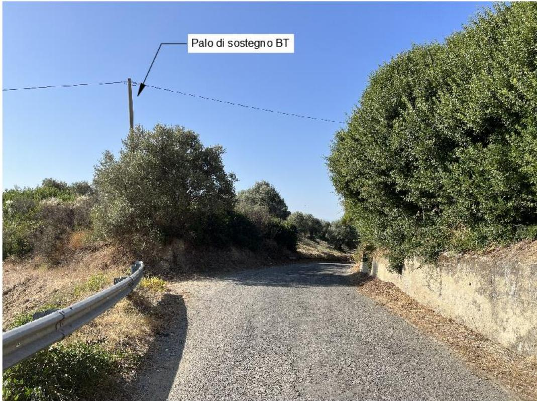
Figura 46: Interferenza tra la viabilità da adeguare/attraversamento cavidotto MT e linea aere BT (Punto I – LA53)
