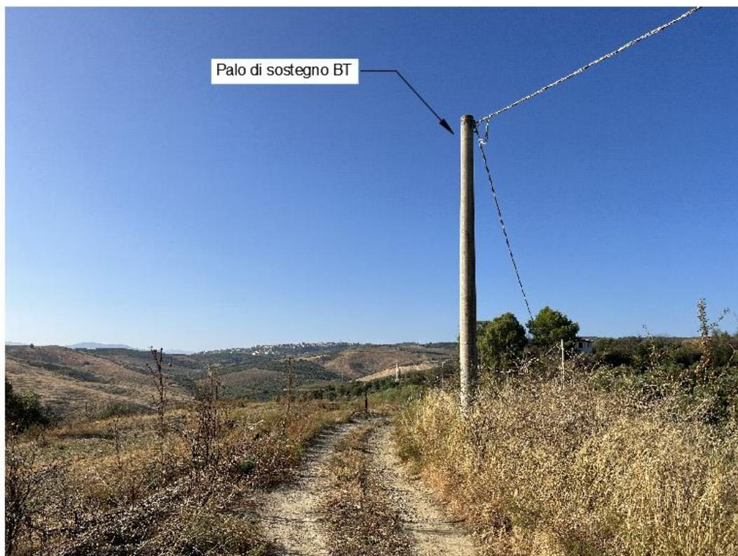
Figura 22: Interferenza tra la viabilità da adeguare/attraversamento cavidotto MT e linea aere BT (Punto I – LA13)
