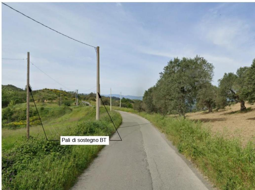
Figura 48: Interferenza tra la viabilità da adeguare e linea aere BT (Punto I – LA54)
