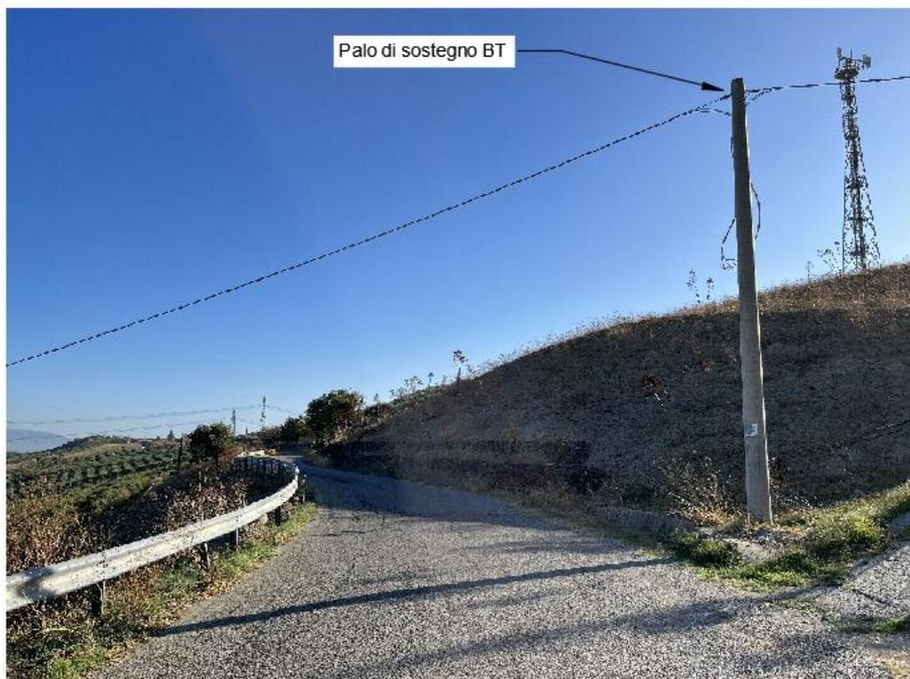
Figura 28: Interferenza tra cavidotto MT e linea aere BT (Punto I – LA23)
