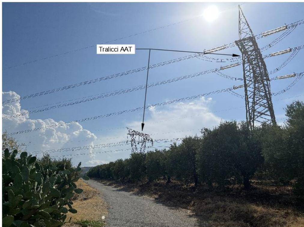
Figura 18: Interferenza tra la viabilità da adeguare/attraversamento cavidotto MT e linea aere ATT (Punto I – LA5)
