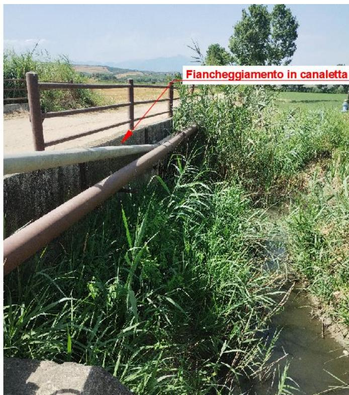
**Fiancheggiamento in canaletta del cavidotto AT**
