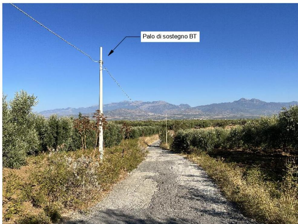
Figura 31: Interferenza tra la viabilità da adeguare/attraversamento cavidotto MT e linea aere BT (Punto I – LA14)
