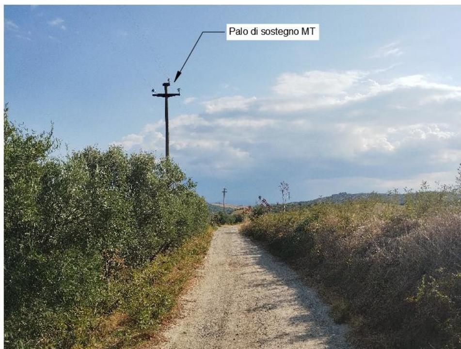
Figura 20. Interferenza tra la viabilità da adeguare/attraversamento cavidotto MT e linea aere MT (Punto I – LA11)
