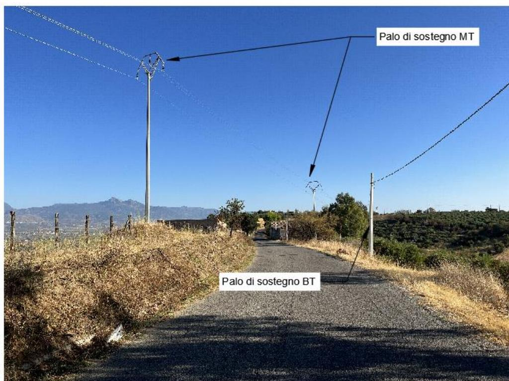
Figura 25: Interferenza tra la viabilità da adeguare/attraversamento cavidotto MT e linea aere BT (Punto I – LA18)
