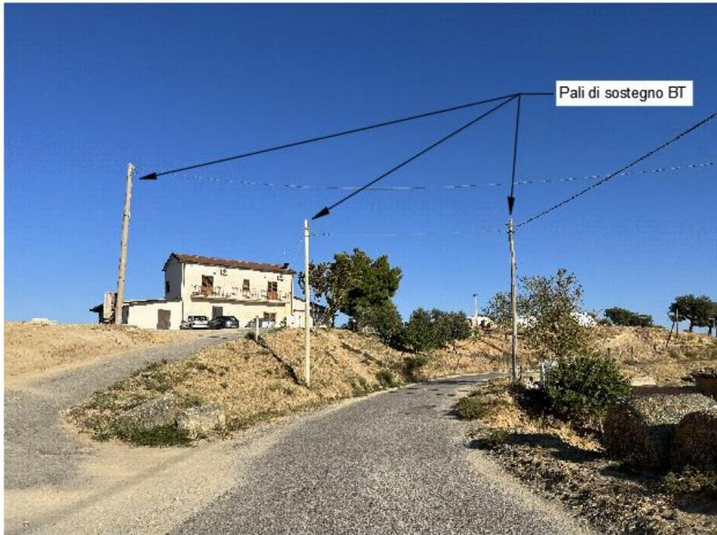
Figura 55: Interferenza tra la viabilità da adeguare/attraversamento cavidotto MT e linea aere BT (Punto I – LA67)
