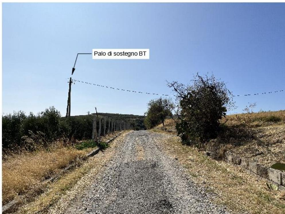
Figura 30: Interferenza tra cavidotto MT e linea aere BT (Punto I – LA30)
