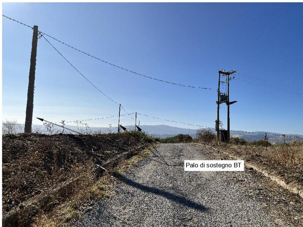
Figura 32: Interferenza tra la viabilità da adeguare/attraversamento cavidotto MT e linea aere BT (Punto I – LA35)
