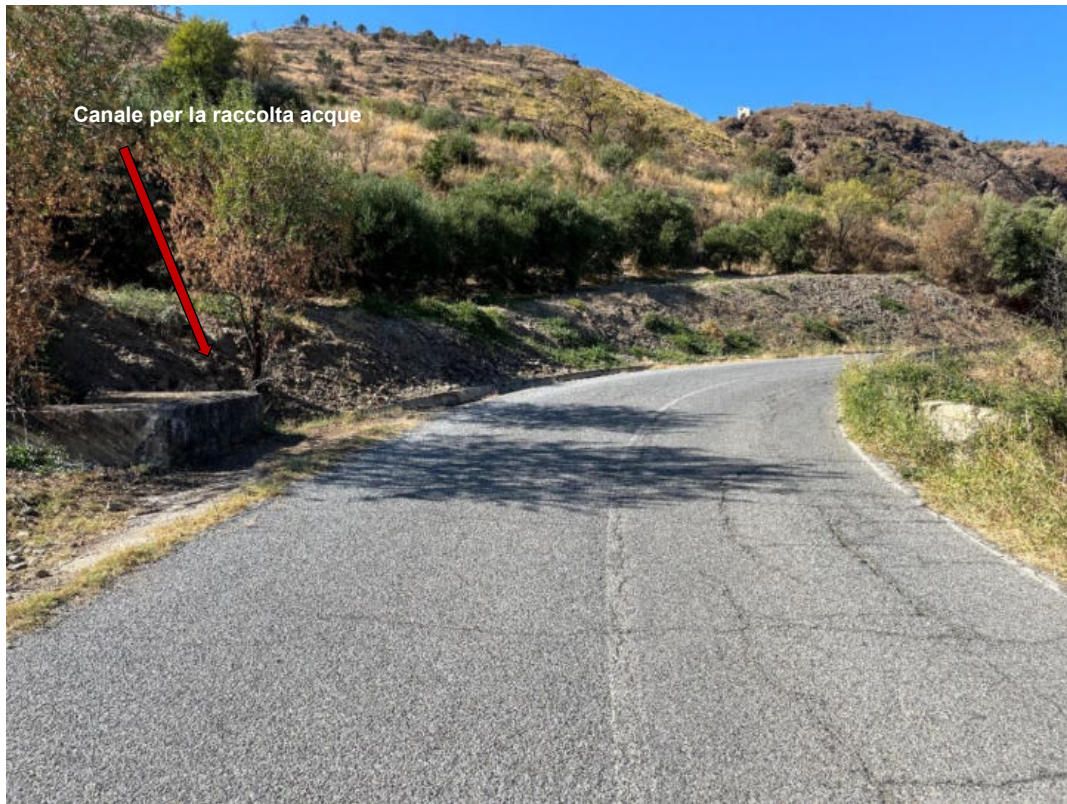
Foto 86: PV86 – Tratto di strada asfaltata interessato dal passaggio del cavidotto e presenza del canale raccolta acque. (Coordinate: N39°38'47.29"; E16°20'52.83" m N)
