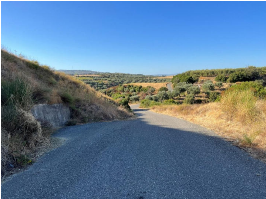
Foto 117: PV117 – Tratto di strada asfaltata interessato dal passaggio del cavidotto. (Coordinate: N39°37'22.01"; E16°21'45.28" m N)
