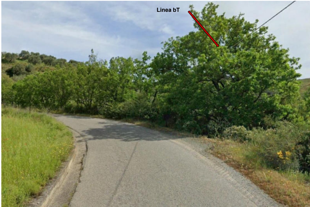
Foto 131: PV131 – Tratto di strada asfaltata interessato dalla presenza del cavidotto e dalla presenza della linea bT. (Coordinate: N 39°36'19.89; 16°20'0.15"E m N)
