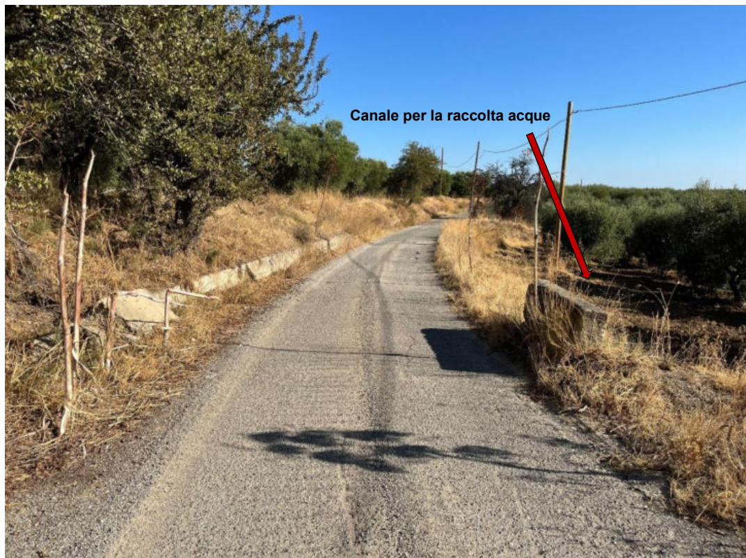
Foto 63: PV63 – Tratto di strada asfaltata interessato dal passaggio del cavidotto e la presenza del canale per la raccolta delle acque. (Coordinate: N39°41'17.39"; E16°21'56.33" m N)
