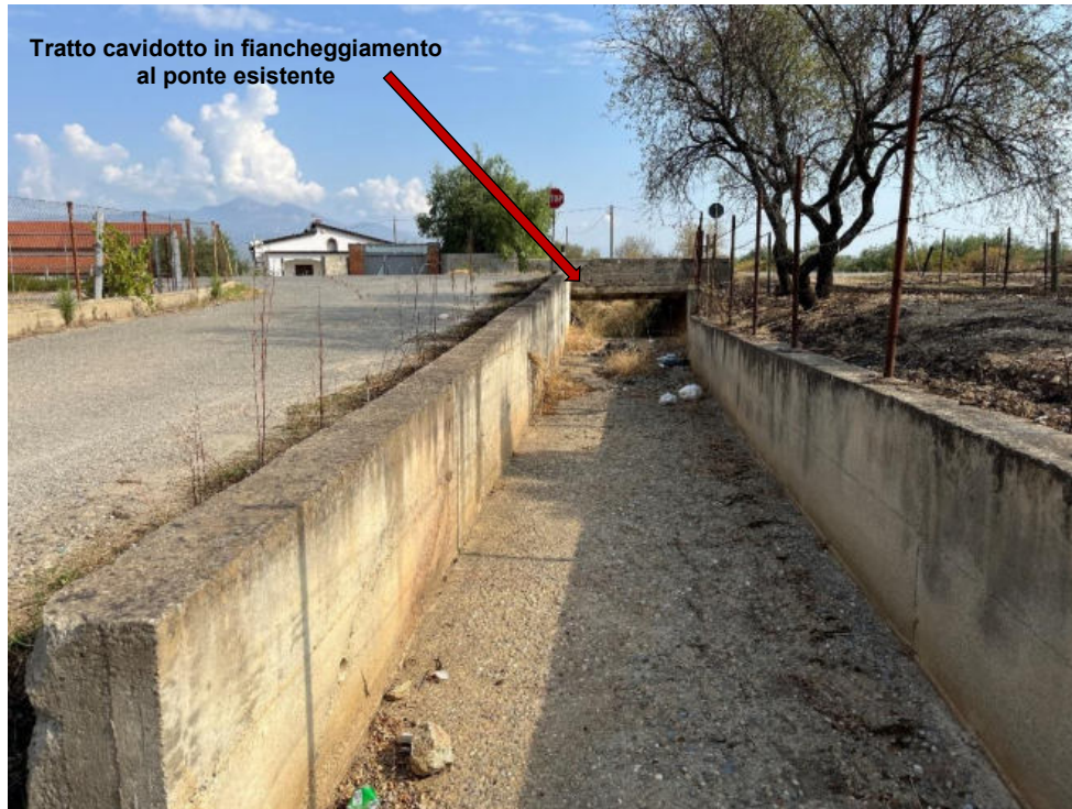
Foto 9: Pv9 - Tratto di strada asfaltata interessato dal passaggio del cavidotto. Sulla destra, il passaggio del cavidotto in fiancheggiamento al ponte esistente. (Coordinate: N39°42'37.26"; E16°19'50.18" m N)
