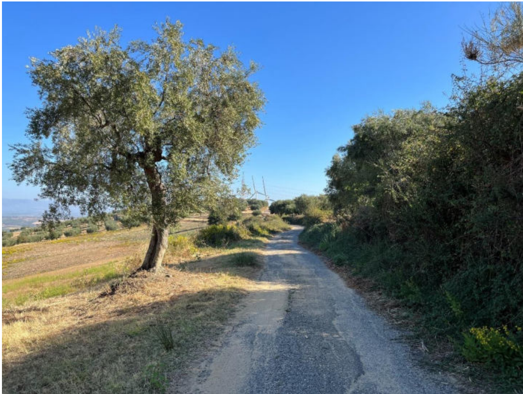
Foto 114: PV114 - Tratto di strada asfaltata interessato dal passaggio del cavidotto. (Coordinate: N39°36'39.81"; E16°21'29.88" m N)
