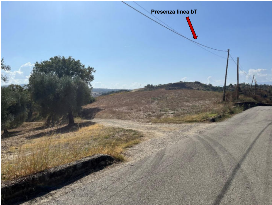
Foto 97: PV97 – Tratto di strada asfaltata interessato dal passaggio del cavidotto e presenza linea bT. (Coordinate: N39°36'19.89"; E16°19'23.46"m N)
