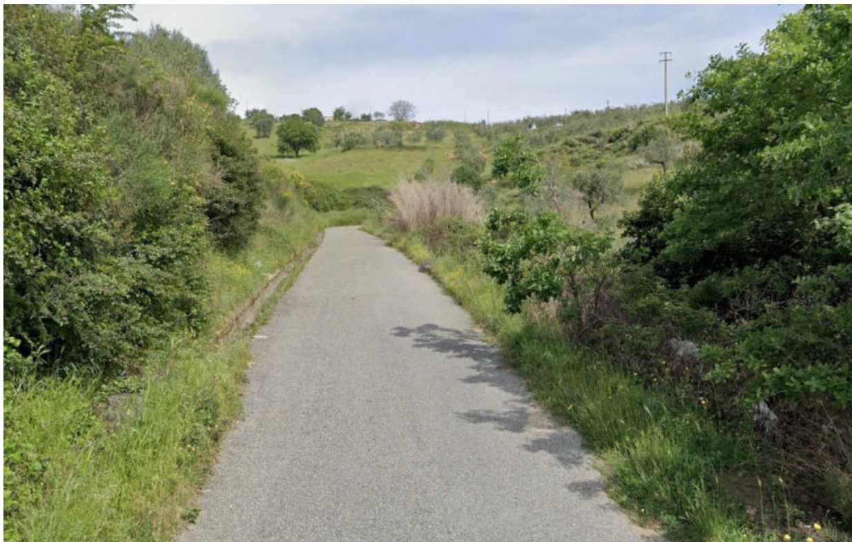
Foto 132: PV132 – Tratto di strada asfaltata interessato dalla presenza del cavidotto. (Coordinate: N 39°36'29.44; 16°20'1.44"E m N)
