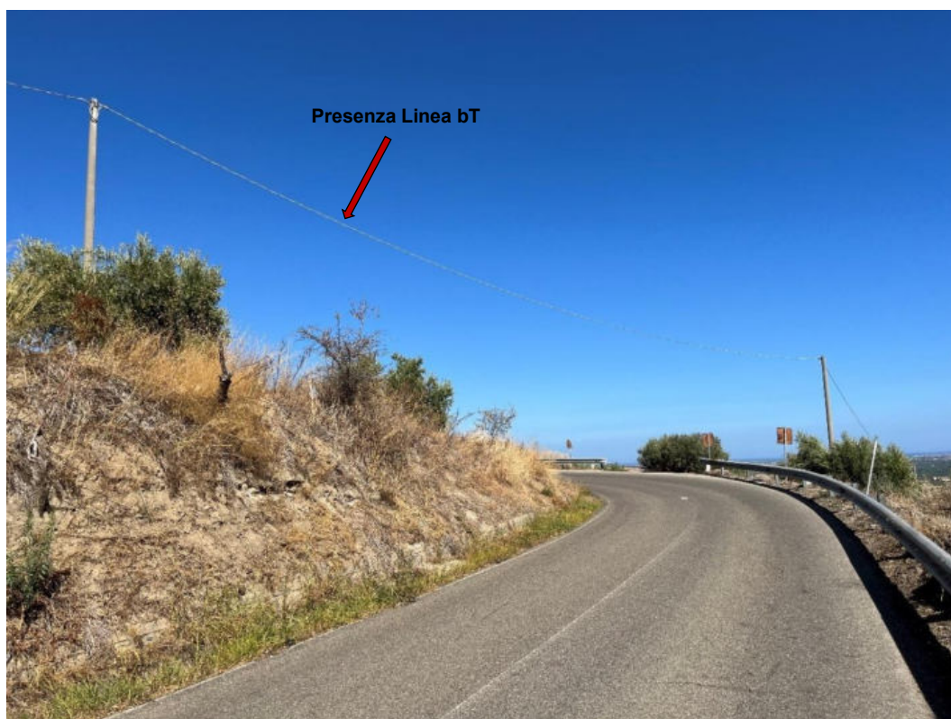
Foto 82: PV82 – Tratto di strada asfaltata interessato dal passaggio del cavidotto e presenza del canale raccolta acque. (Coordinate: N39°39'37.87"; E16°20'46.98" m N)
