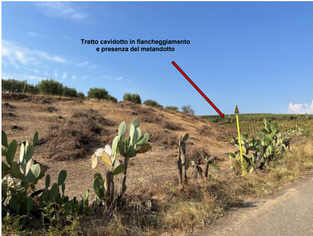
Foto 7: PV7 - Tratto di strada interessato al passaggio del cavidotto e la presenza del metandotto. (Coordinate: N39°42'31.92"; E16°19'32.45" m N)
