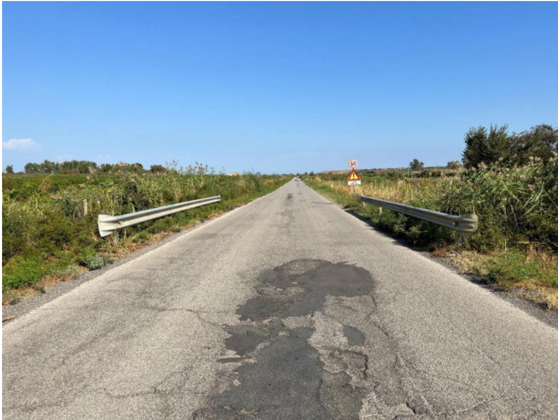
Foto 24: PV24 – Tratto di strada asfaltata interessata dal passaggio del cavidotto. (Coordinate N39°42'20.99"; E16°20'56.57" m N)
