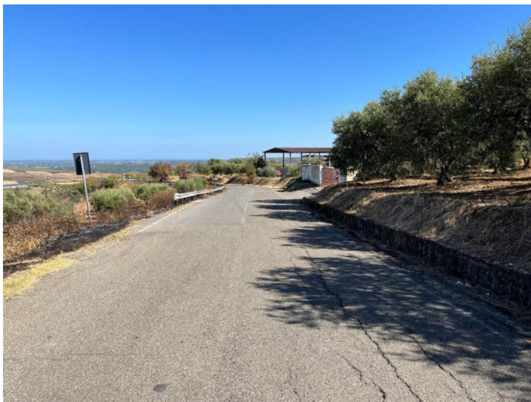
Foto 81: PV81 – Tratto di strada asfaltata interessato dal passaggio del cavidotto. (Coordinate: N39°39'37.87"; E16°20'46.98" m N)
