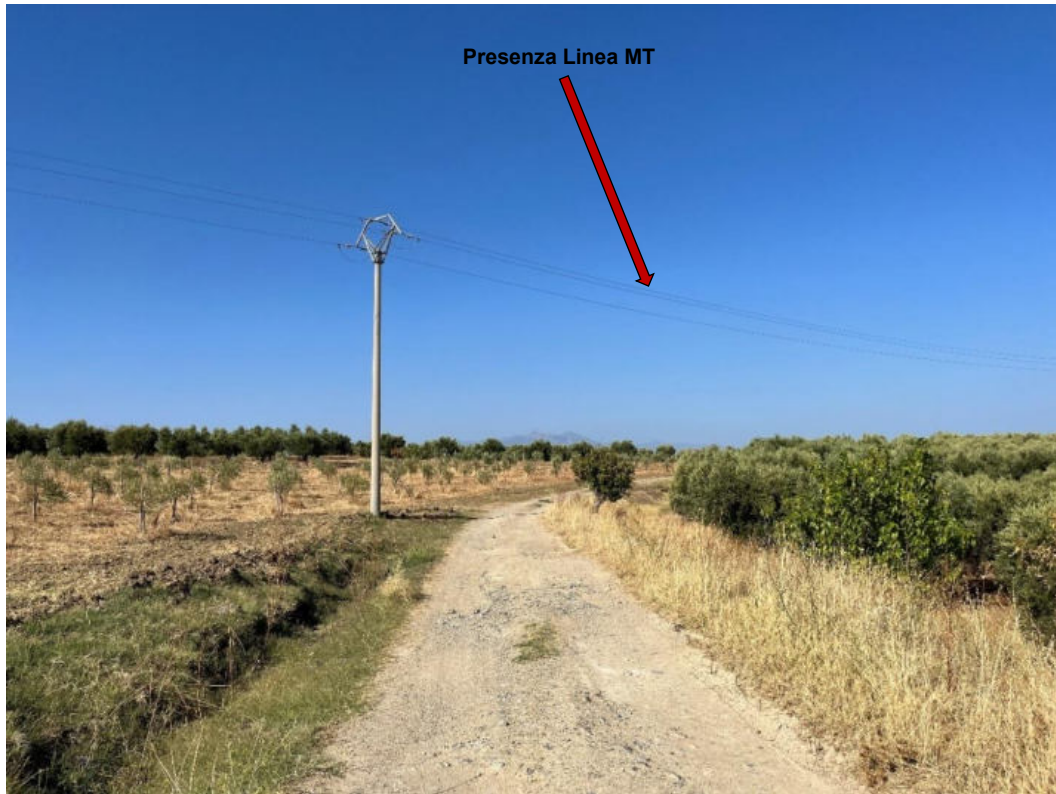
Foto 50: PV50 - Tratto di strada bianca interessato dal passaggio del cavidotto e della presenza della linea MT. (Coordinate: N39°40'17.38"; E16°21'3.11"m N)
