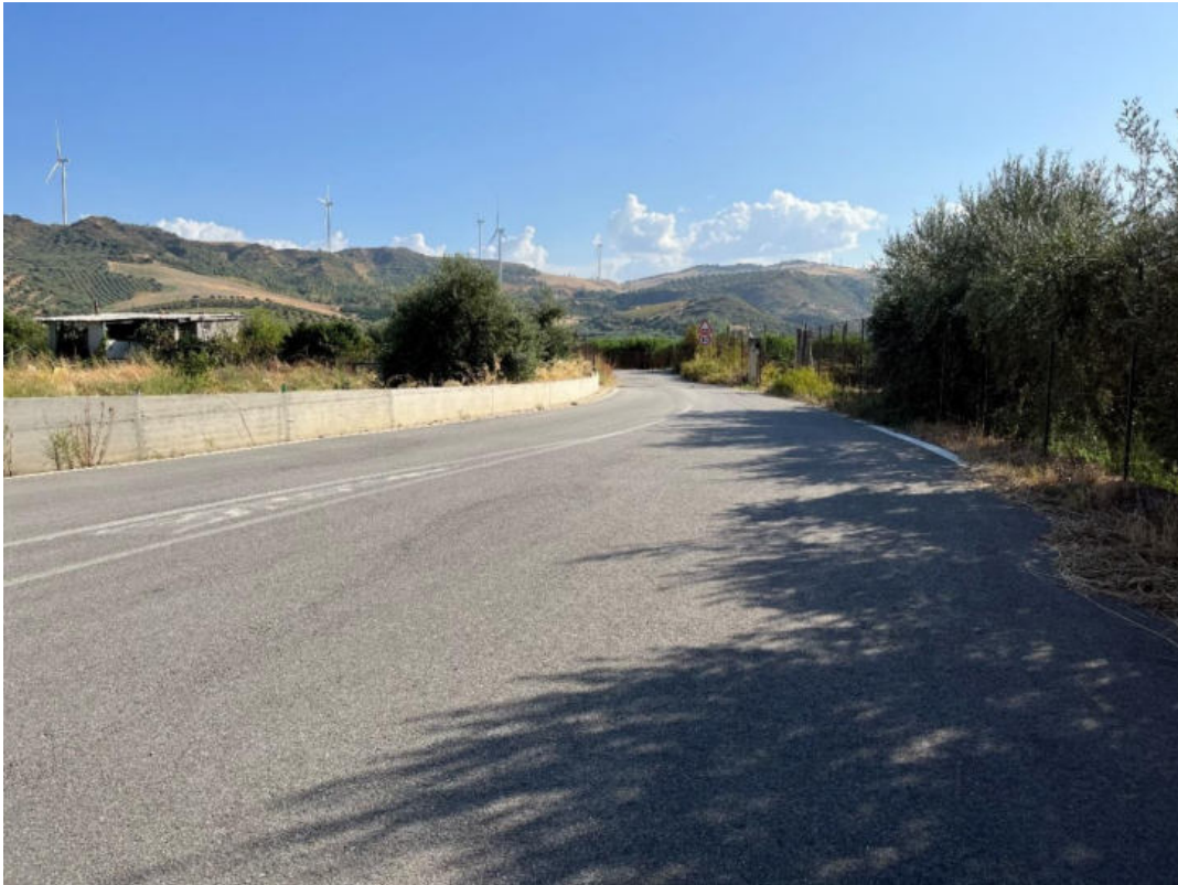
Foto 106: PV106 – Tratto di strada asfaltata interessata dal passaggio del cavidotto. (Coordinate: N39°38'25.85"; E16°21'33.97" m N)
