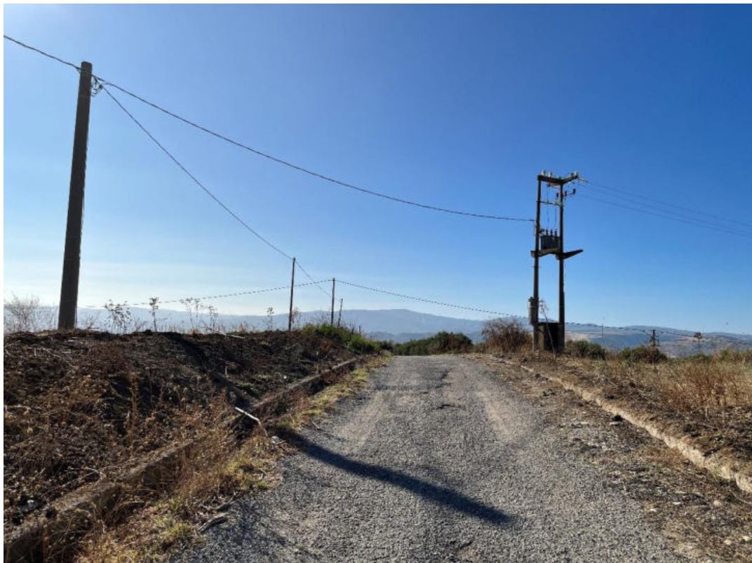
Foto 65: PV65 – Tratto di strada asfaltata interessato dal passaggio del cavidotto e la presenza della linea bT verso la STT13. (Coordinate: N39°40'55.17"; E16°22'1.31" m N)
