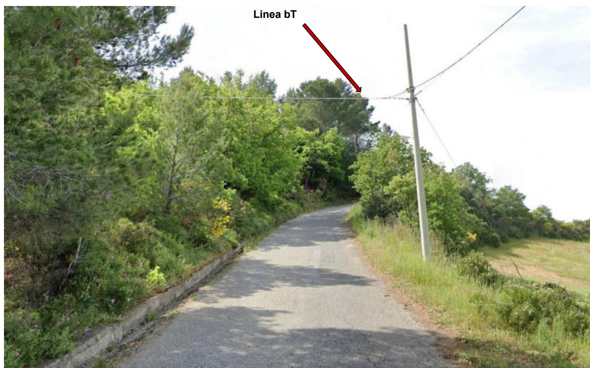
Foto 128: PV128 – Tratto di strada asfaltata interessato dalla presenza del cavidotto e della linea bT verso la STT26. (Coordinate: 39°36'4.98"; 16°20'7.92"Em N)
