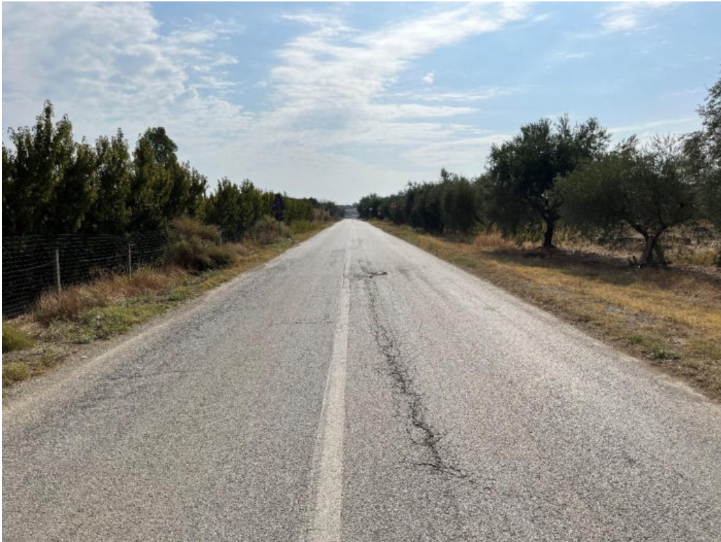
Foto 12: PV12 - Tratto di strada asfaltata interessato dal passaggio del cavidotto. (Coordinate: N39°42'25.82"; E16°20'18.99"m N)
