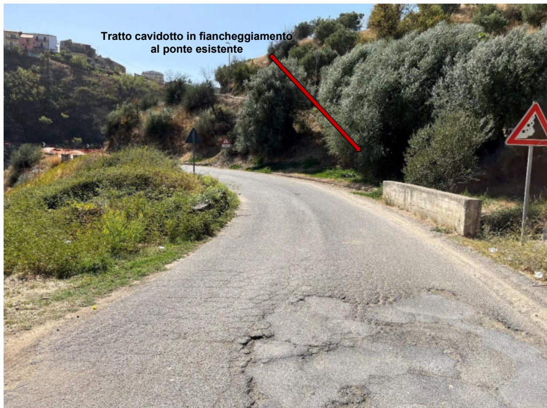
Foto 47: PV47 – Tratto di strada asfaltata interessato dal passaggio del cavidotto e dell'attraversamento su ponte esistente. (Coordinate: N39°39'44.02"; E16°20'17.66"m N)
