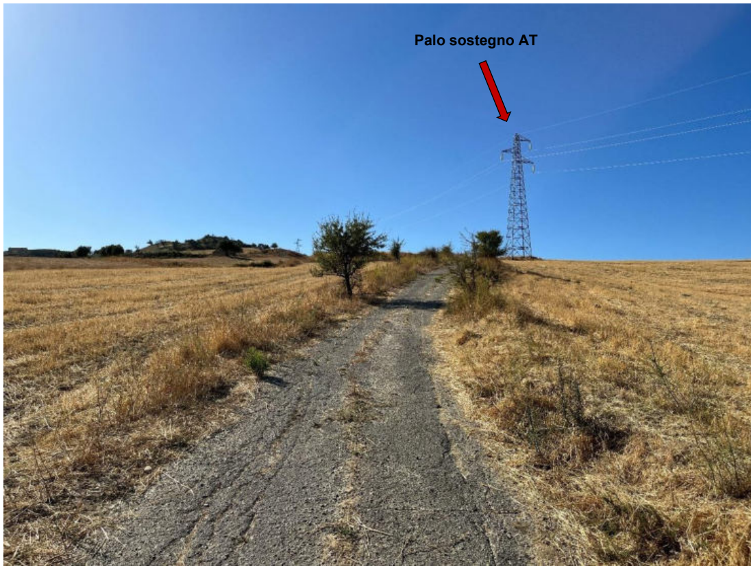
Foto 112: PV112 - Tratto di strada asfaltata interessato dal passaggio del cavidotto e passaggio della linea AT. (Coordinate: N39°37'22.01"; E16°21'45.28" m N)
