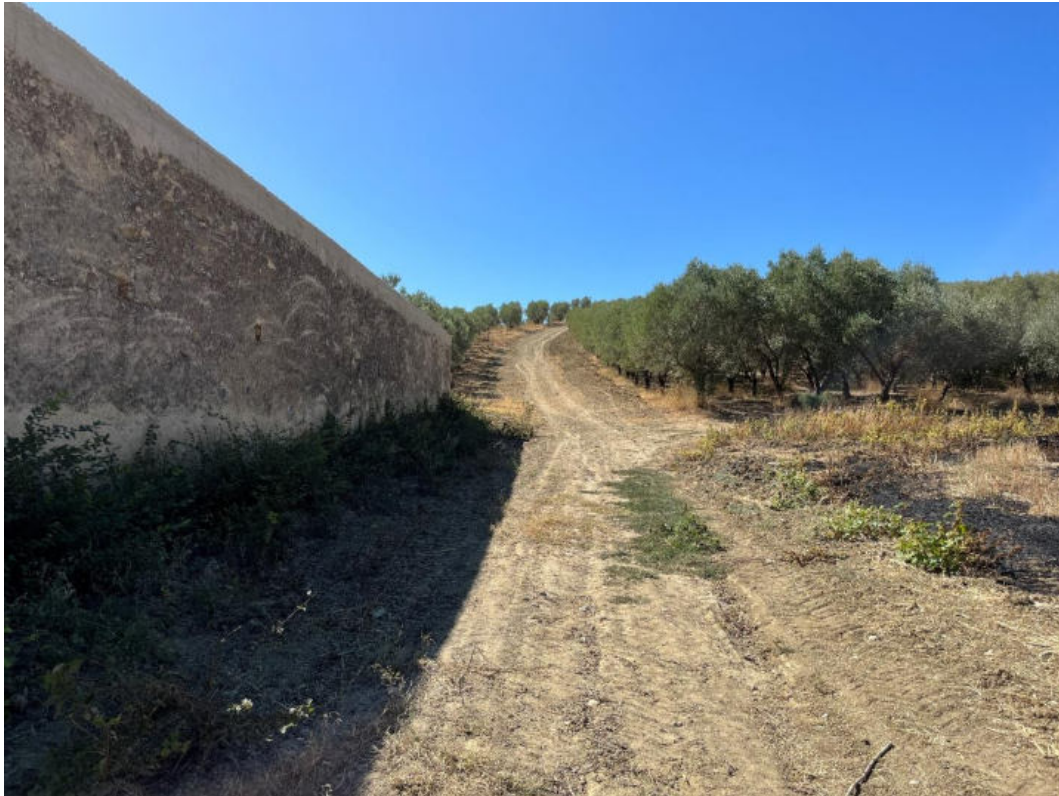
Foto 77: PV77 – Tratto di strada sterrata interessato dal passaggio del cavidotto verso STT18. (Coordinate: N39°40'23.67"; E16°23'29.13" m N)
