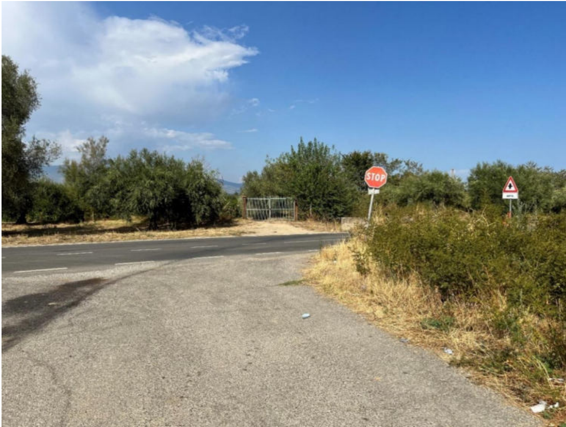
Foto 14: PV14 - Tratto di strada asfaltata interessata dal passaggio del cavidotto con interferenza attraversamento ponte esistente. (Coordinate: N39°42'19.85"; E16°20'48.25" m N)
