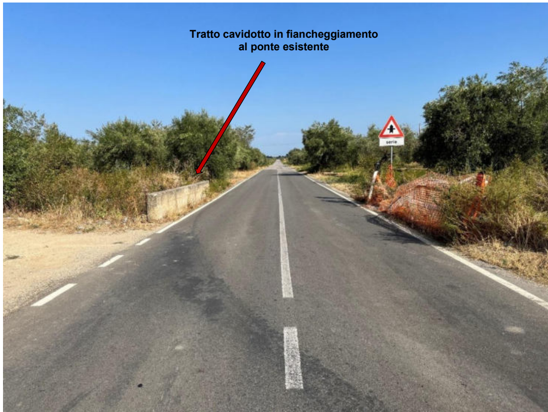
Foto 16: PV16 – Tratto di strada asfaltata interessata dal passaggio del cavidotto. Sulla sinistra, il passaggio del cavidotto in fiancheggiamento al ponte esistente. (Coordinate: N39°42'20.34"; E16°20'48.39"m N)
