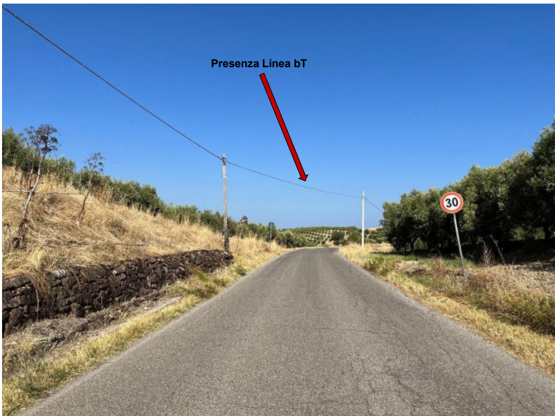
Foto 49: PV49 - Tratto di strada bianca interessato dal passaggio del cavidotto e della presenza della linea bT. (Coordinate: N39°40'12.31"; E16°20'48.12"m N)
