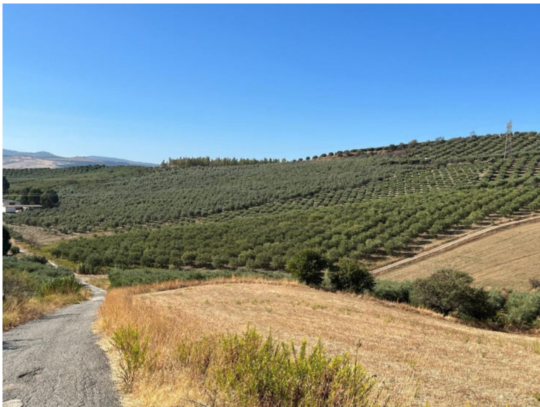
Foto 68: PV68 – Tratto di strada asfaltata interessato dal passaggio del cavidotto verso la STT 14. (Coordinate: N39°40'28.42"; E16°22'7.70"m N)
