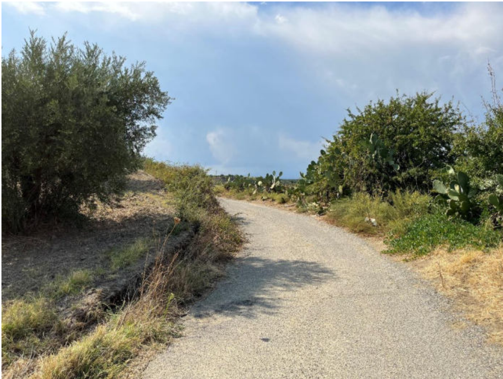
Foto 18: PV18 – Tratto di strada asfaltata interessato dal passaggio del cavidotto. (Coordinate: N39°42'13.08"; E16°20'44.13" m N)
