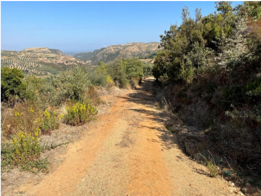
Foto 101: PV101 - Tratto di strada sterrata interessato dal passaggio del cavitotto. (Coordinate: N39°35'48.83"; E16°19'33.48" m N)
