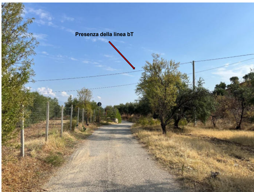
Foto 8: PV8 - Tratto di strada bianca interessato dal passaggio del cavidotto e linea bT. (Coordinate: N39°42'34.12"; E16°19'47.16" m N)
