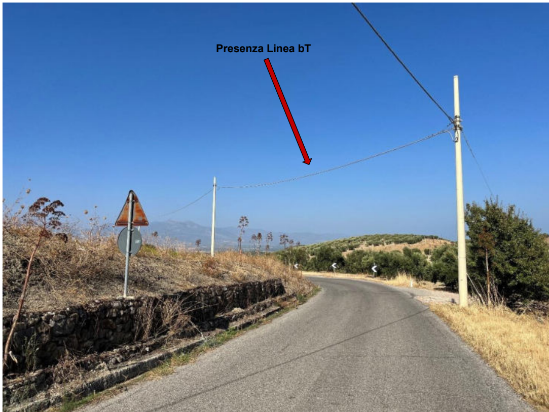
Foto 48: PV48 - Tratto di strada bianca interessato dal passaggio del cavidotto e della presenza della linea bT. (Coordinate: N39°40'2.23"; E16°20'36.02" m N)
