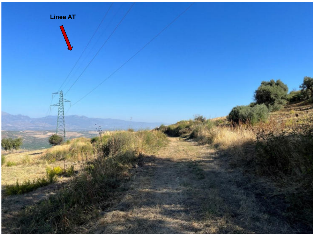
Foto 113: PV113 - Tratto di strada sterrata interessato dal passaggio del cavidotto con presenza della linea AT. (Coordinate: N39°36'54.87"; E16°21'38.73"m N)
