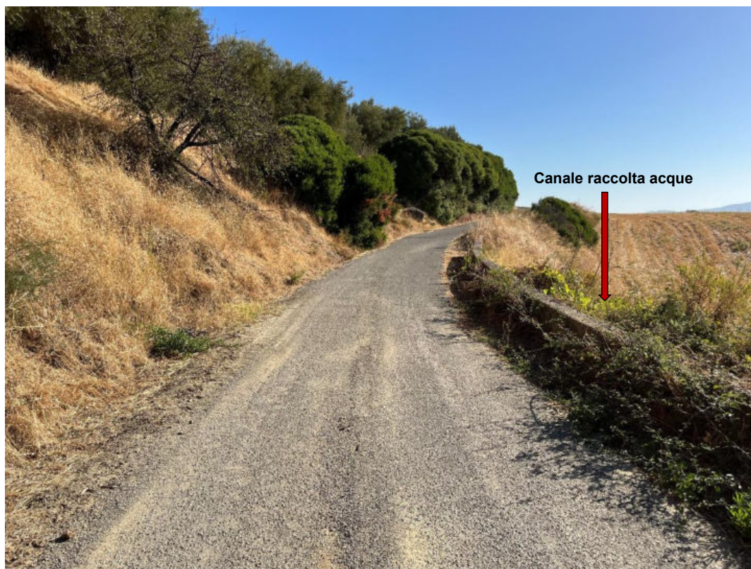
Foto 118: PV118 – Tratto di strada asfaltata interessato dal passaggio del cavidotto e dal canale raccolta acque. (Coordinate: N39°36'23.49"; E16°21'2.12" m N)
