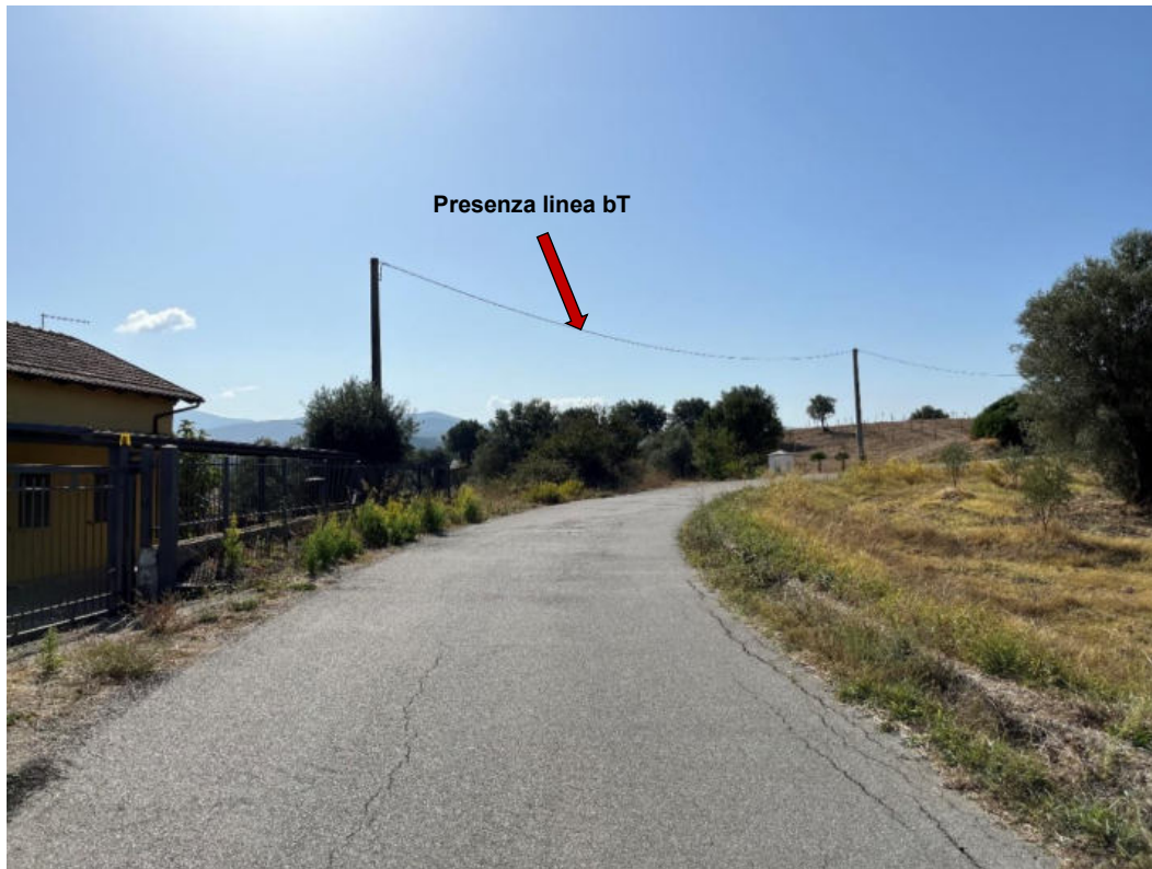
Foto 95: PV95 – Tratto di strada asfaltata interessato dal passaggio del cavidotto e dalla presenza di linea bT verso la STT23. (Coordinate: N39°36'36.85"; E16°19'34.14" m N)
