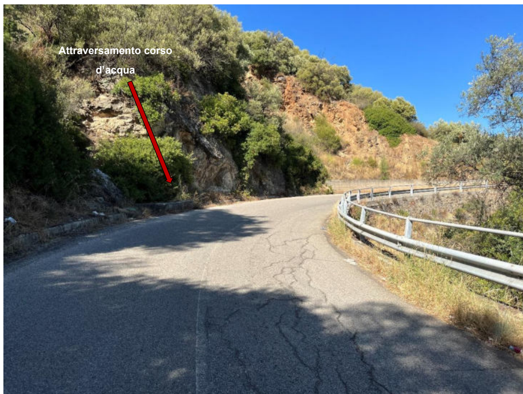
Foto 84: PV84 – Tratto di strada asfaltata interessato dal passaggio del cavidotto e presenza di un attraversamento di un corso d'acqua. (Coordinate: N39°39'12.72"; E16°21'2.93" m N)
