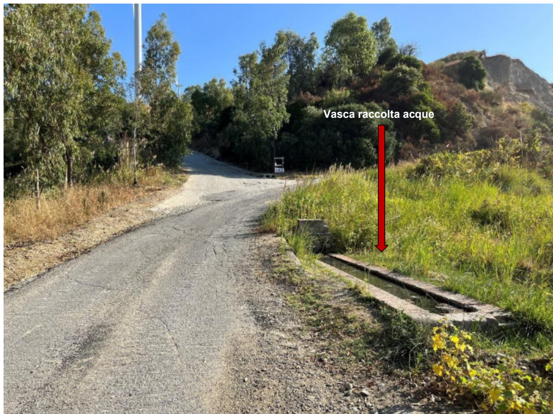
Foto 109: PV109 - Tratto di strada asfaltata interessato dal passaggio del cavidotto e attraversamento raccolta acque interessato dalla presenza di una vasca. (Coordinate: N39°37'35.38"; E16°21'52.64"m N)
