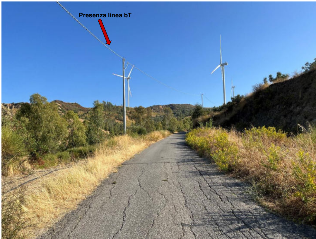
Foto 108: PV108 - Tratto di strada asfaltata interessato dal passaggio del cavidotto e dalla presenza della linea bT. (Coordinate: 613173.00 m E; 4388837.00 m N)
