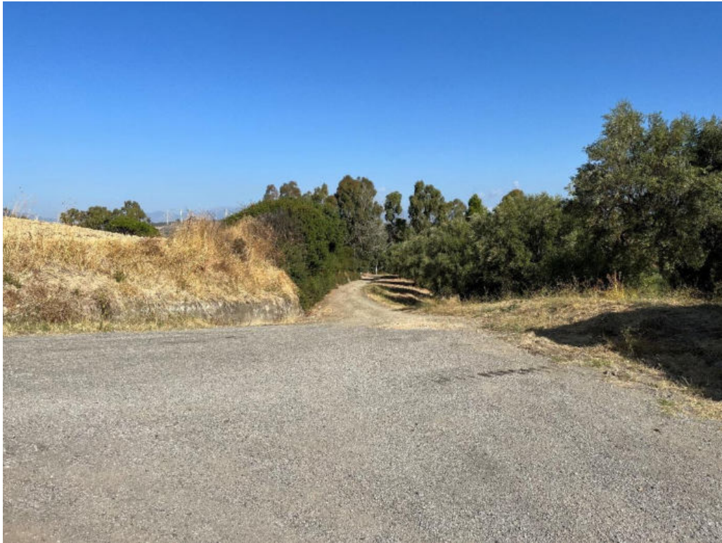
Foto 91: PV91 – Tratto di strada bianca e tratto di strada asfaltata interessato dal passaggio del cavidotto. (Coordinate: N39°36'42.17"; E16°19'59.72" m N)
