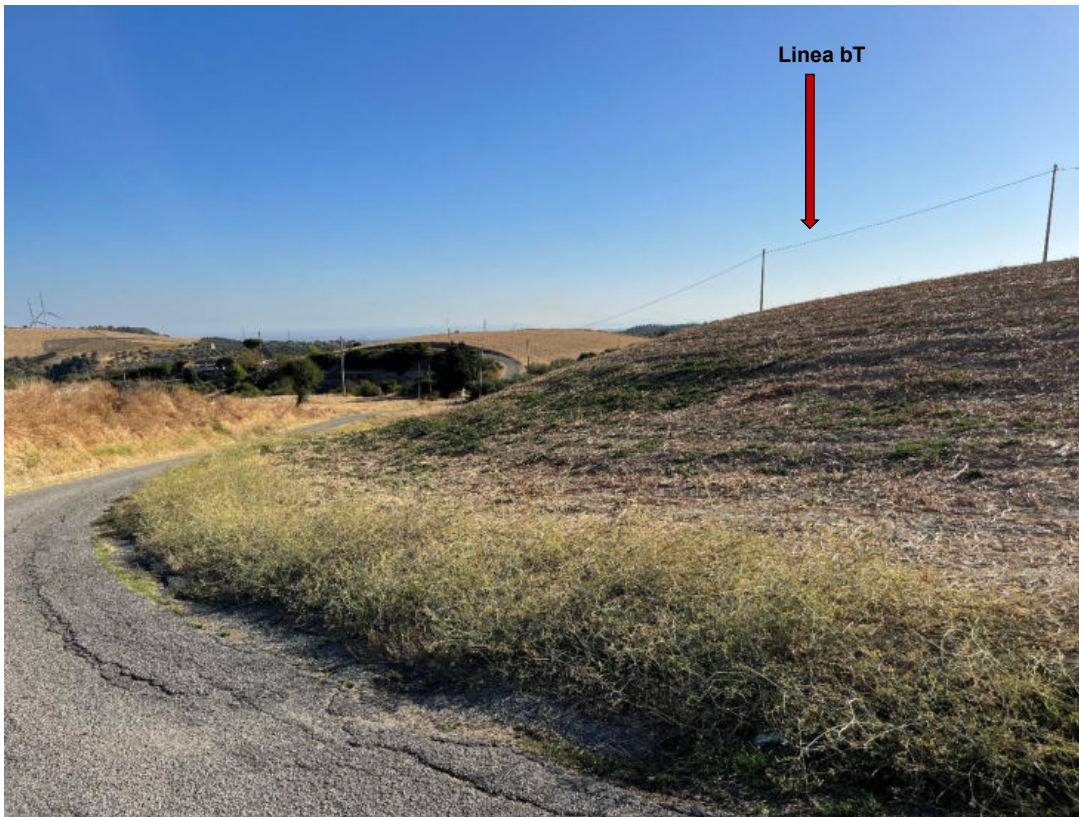
Foto 121: PV121 – Tratto di strada asfaltata interessata dal passaggio del cavidotto e dalla presenza di linea bT. (Coordinate: N39°35'54.43"; E16°20'57.10"m N)
