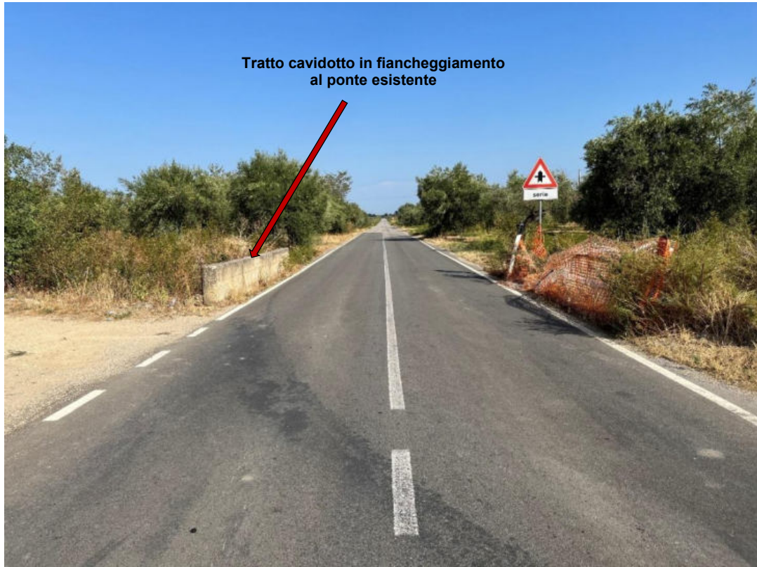
Foto 5: PV5 – Tratto di strada asfaltata interessato dal passaggio del cavidotto. Sulla sinistra, il passaggio del
