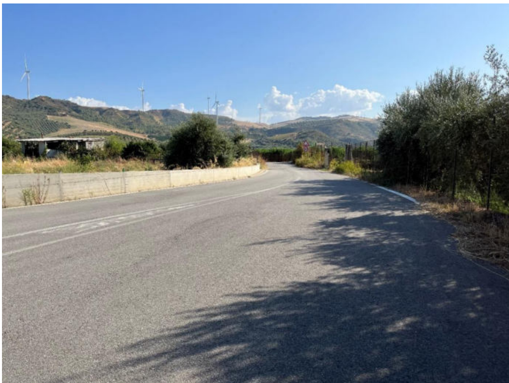
Foto 29: PV29 – Tratto di strada asfaltata interessata dal passaggio del cavidotto. (Coordinate: N39°38'25.85"; E16°21'33.97"m N)
