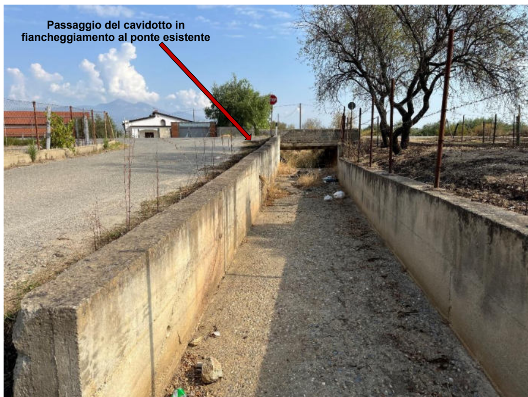
Foto 4: PV4 - Tratto di strada asfaltata interessato dal passaggio del cavidotto. Sulla destra, il passaggio del cavidotto in fiancheggiamento al ponte esistente. (Coordinate: N39°42'37.26"; E16°19'50.18" m N)
