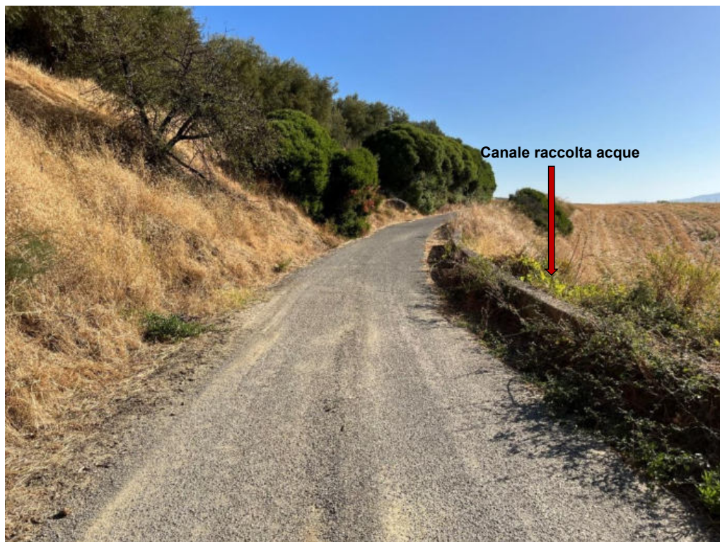
Foto 31: PV31 – Tratto di strada asfaltata interessato dal passaggio del cavidotto e dal canale raccolta acque. (Coordinate: N39°36'23.49"; E16°21'2.12" m N)
