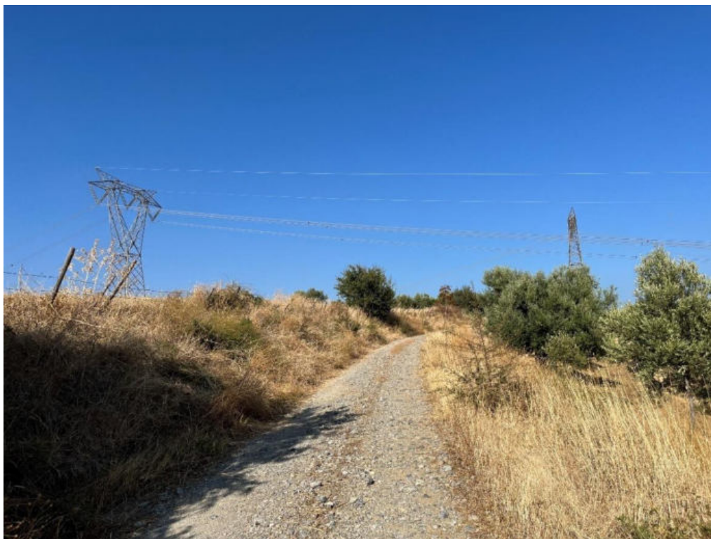
Foto 12: PV12 – Tratto di strada bianca interessato dal passaggio del cavidotto e presenza della linea AT. (Coordinate: 615363.00 m E; 4388949.00 m N)
