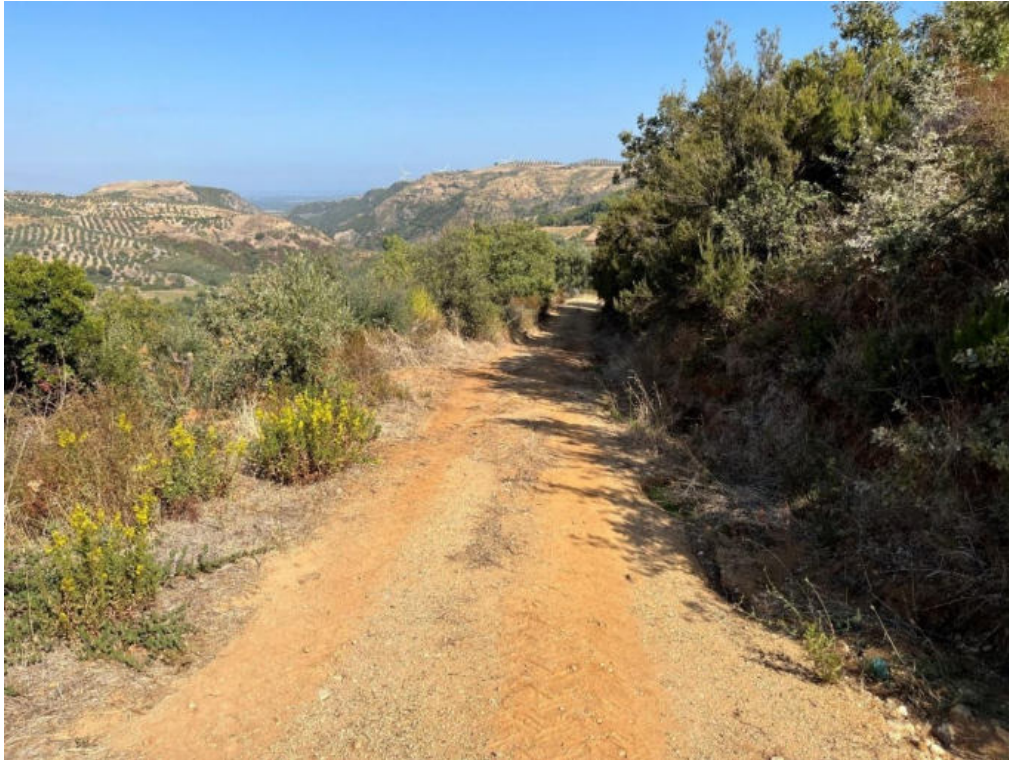
Foto 26: PV26 - Tratto di strada sterrata interessato dal passaggio del cavidotto. (Coordinate: N39°35'48.83"; E16°19'33.48" m N)
