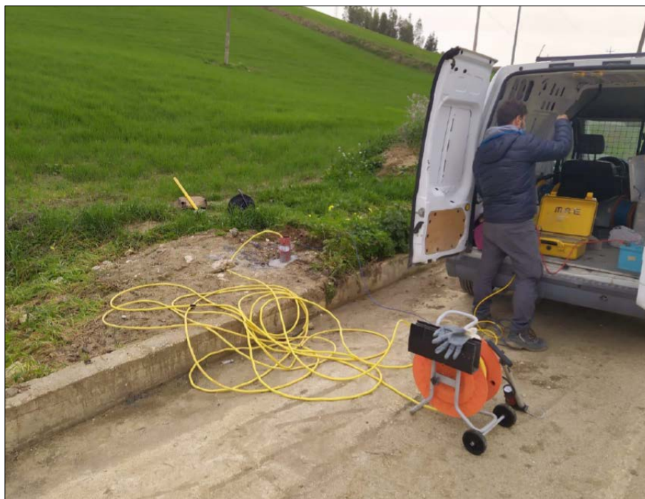
Fig. 25 – Esecuzione prova sismica Down-hole DH_S3
