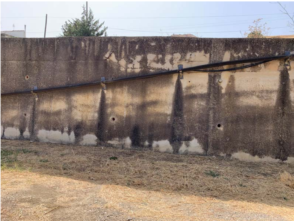
Figura 6-5 Muro di sottoscarpa esistente
