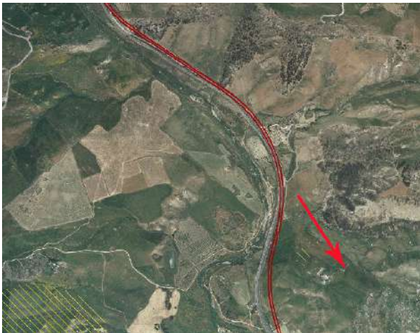
Tratto dal km 34 al km 36 circa Si rilevano tracce di anomalie sul terreno
