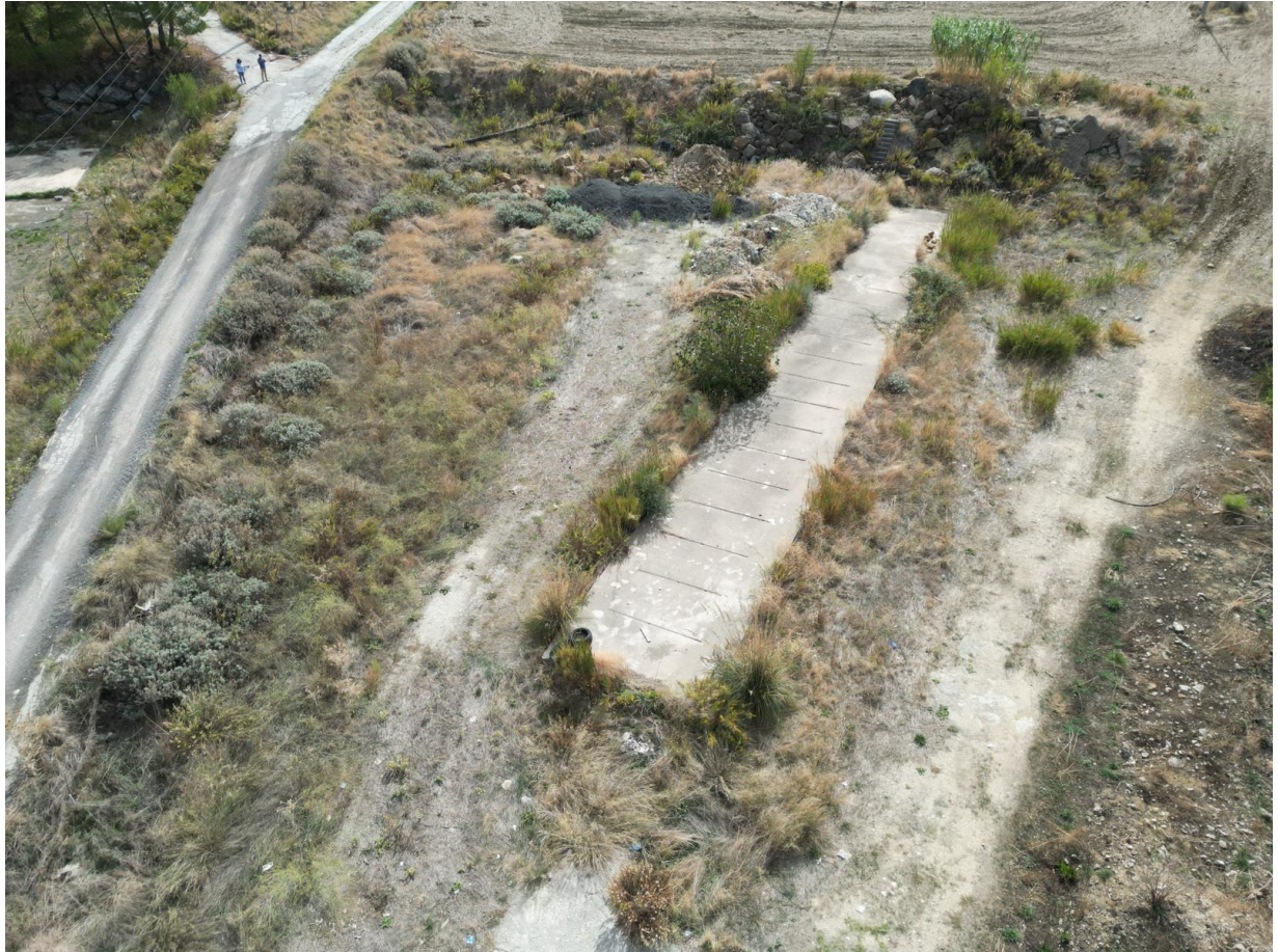
Figura 4 – Foto aerea dell'area del cantiere base CB.01b. Sono visibili le manomissioni recenti, quali: il profondo sbancamento osservabile nel margine superiore; la pista di cantiere in calcestruzzo al centro; il materiale di riporto sparso nell'area
