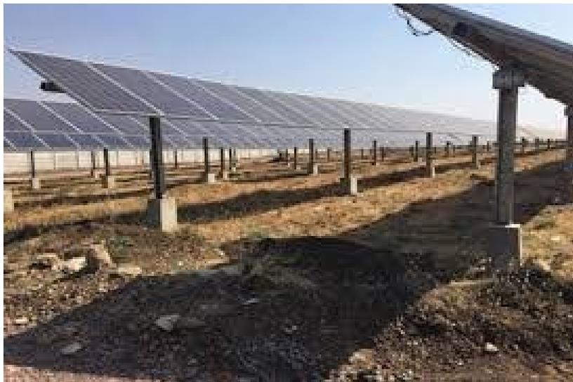
*Figura 3: Esempio di impianto fotovoltaico con fondazioni ottenute mediante perforazione del terreno e successiva creazione del palo di fondazione con getto di cemento.*
