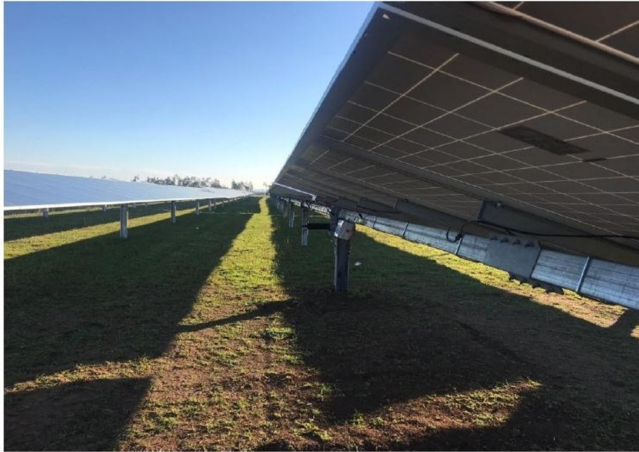
Figura 8: Esempio di impianto fotovoltaico realizzato con supporti costituiti da pali in acciaio infissi direttamente nel terreno.
