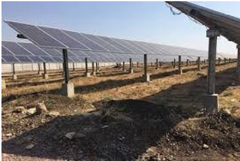
Figura 10: Esempio di impianto fotovoltaico con fondazioni ottenute mediante perforazione del terreno e successiva creazione del palo di fondazione con getto di cemento.
