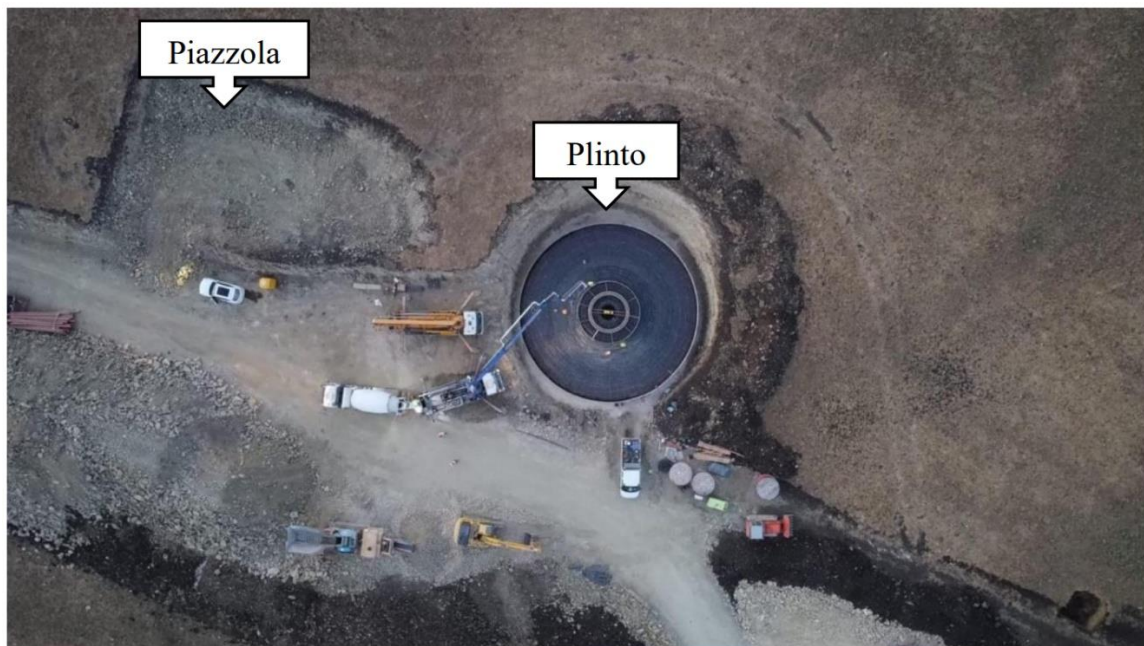
Figura 13 – Posizionamento plinto di fondazione
