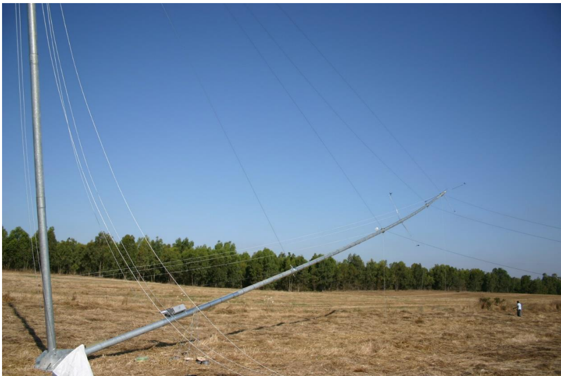
Figura 2 - Installazione Anemometro
