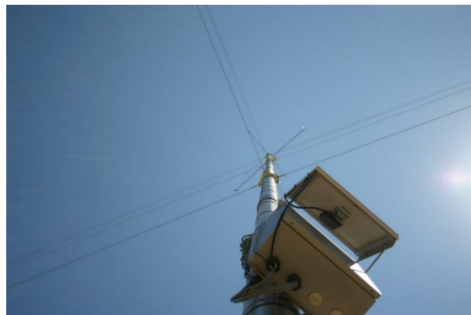
Figura 3 - Installazione Anemometro
