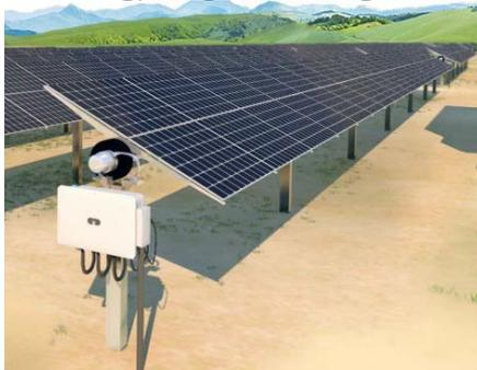
Figura 47- Esempio di installazione gruppo di conversione CC/CA (String Inverters)
