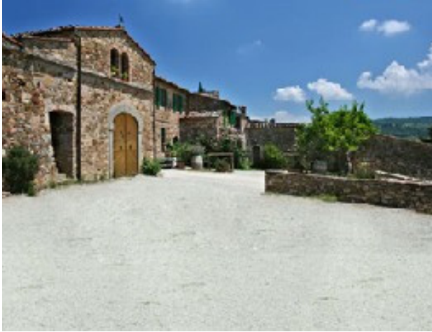
Foto 5 - in materiale stabilizzato
