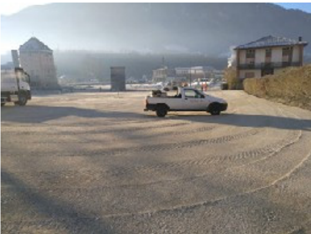
Foto 3 - in materiale drenante
